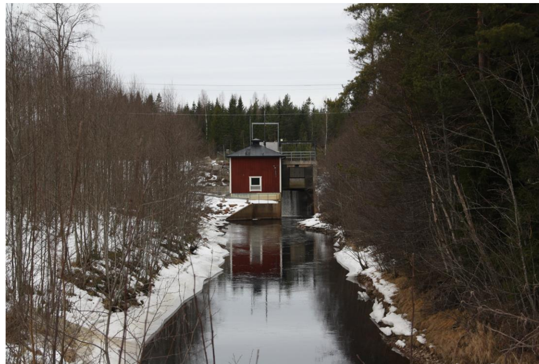
Figur 4. Kraftverk och utloppskanal. Vy från nedströmssidan.
