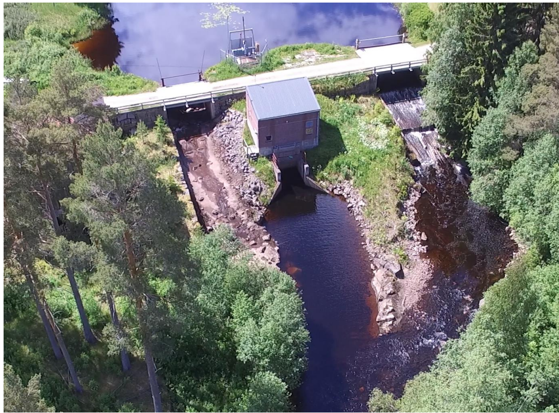
Figur 1. Vänster utskov (i strömriktningen). Vy från nedströmssidan.
