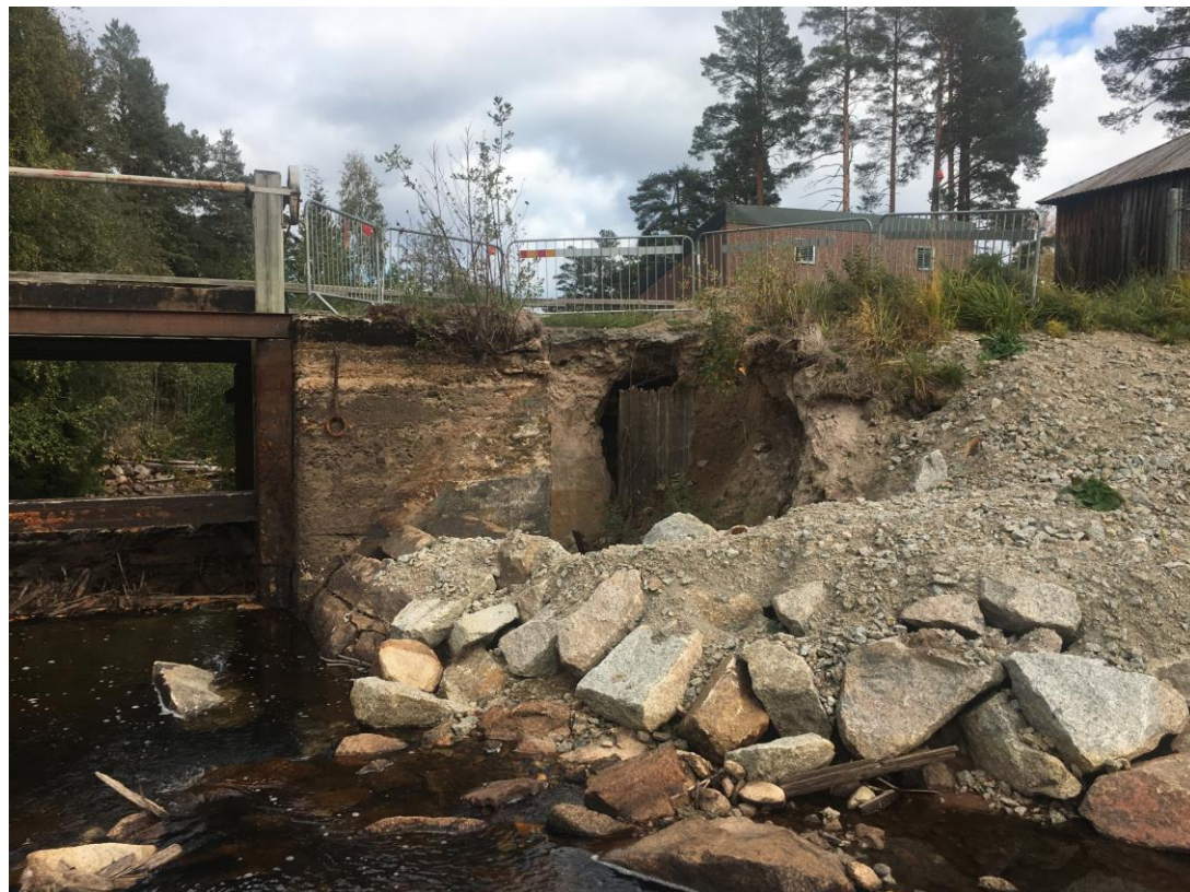
Figur 3. Erosionsskadan i dammvall till höger om utskovet. Skadan är nu lagad
