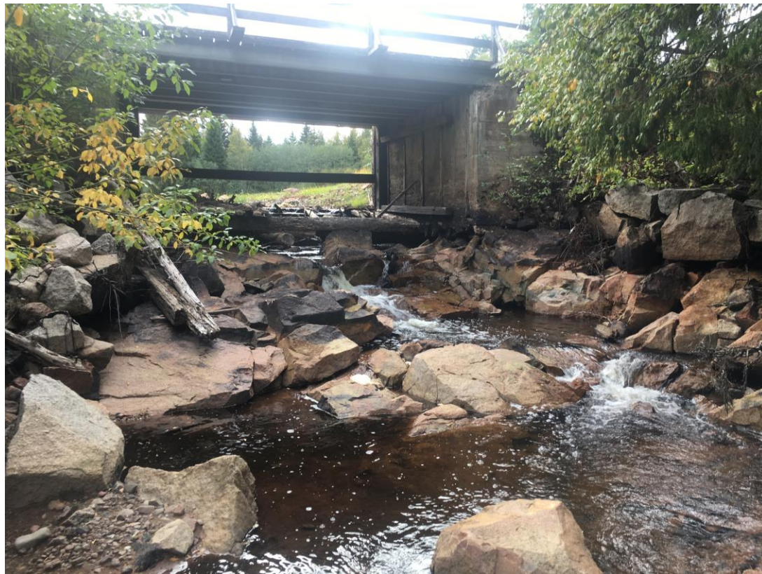
Figur 1. Vänster utskov från nedströmssida med blottlagt berg.
