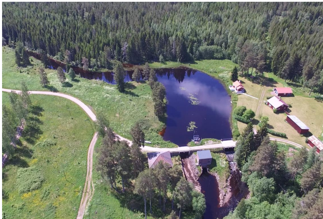
Figur 3. Flygfoto över kraftverk och damm. Vy från nedströmssidan.
