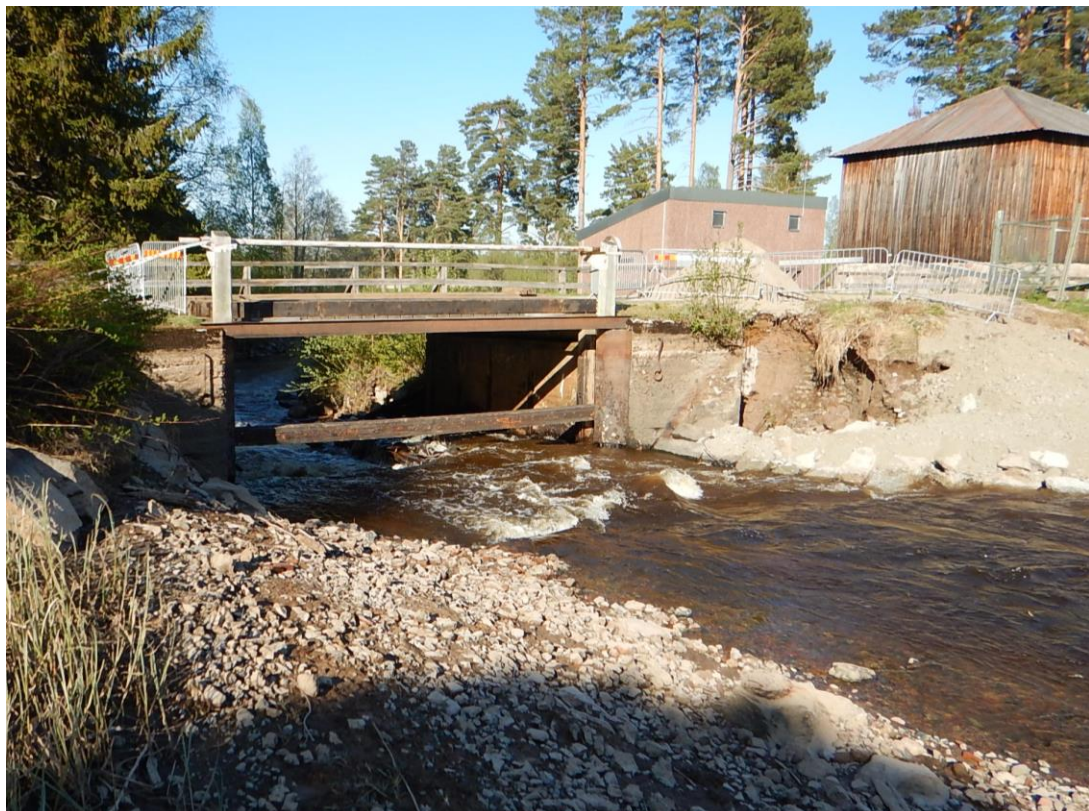
Figur 3. Vänster utskov med borttagna sättar. Erosionsskada i dammvallen till höger i bild. Vy från uppströmssidan.
