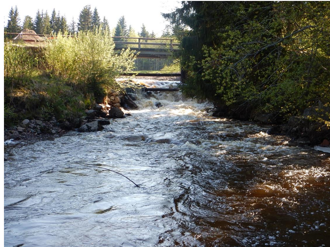
Figur 4. Vänster utskov med borttagna sättar. Vy från nedströmssidan.
