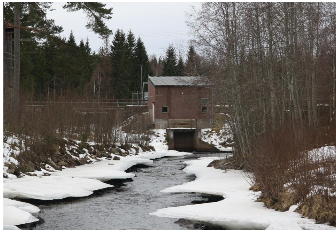
Figur 4. Kraftverk och utloppskanal vid lågvattenstånd i Siljan. Vy från nedströmssidan.
