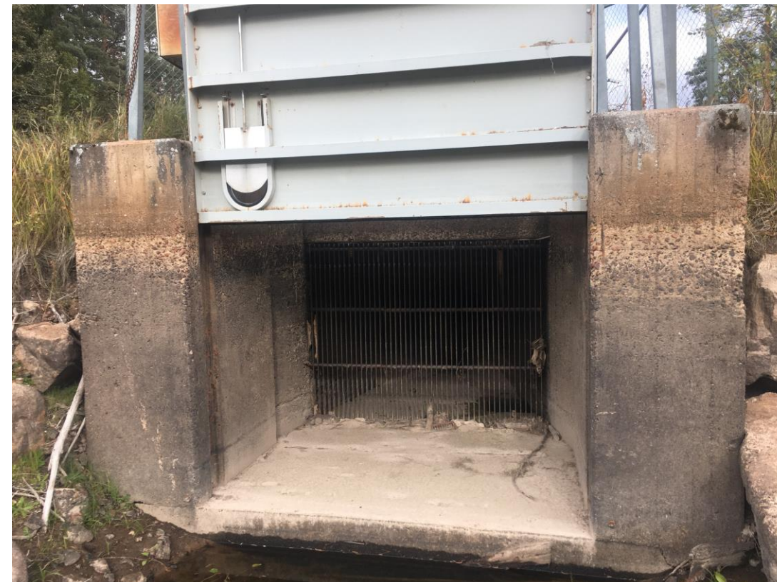
Figur 4. Kraftverksintag i mitten av dammvallen.
