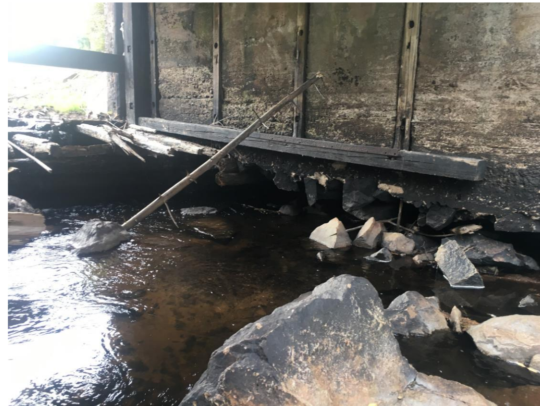
Figur 2. Träkistan som utskovet är grundlagt med har delvis brustit och brofundamenten är underminerade.
