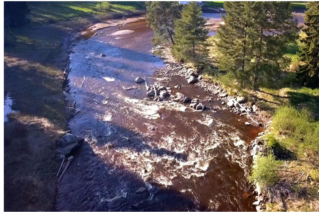
Figur 2. Strömsträckor som bildats direkt ovan kraftverket efter dammbrott vid högvatten. Vy från uppströmssidan.
