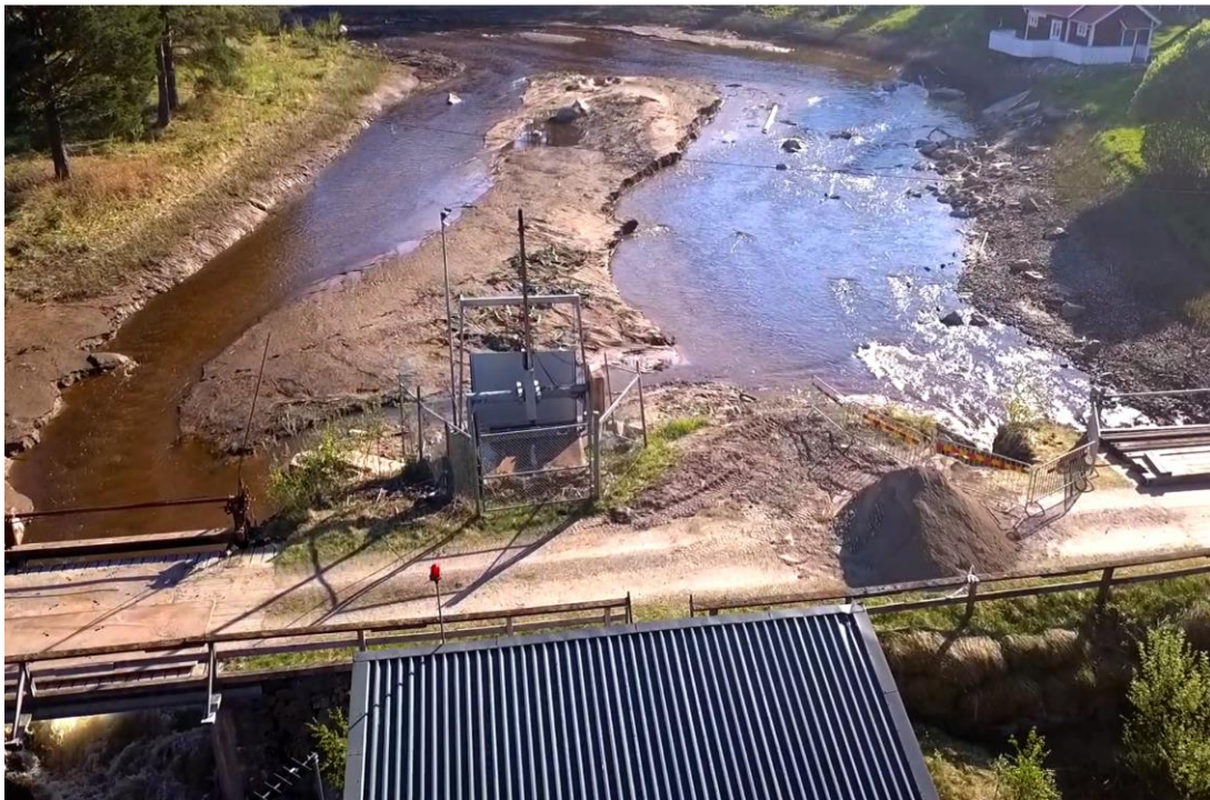
Figur 1. Kraftverksdamm tömd efter dammbrott vid högvatten. Vy från nedströmssidan.
