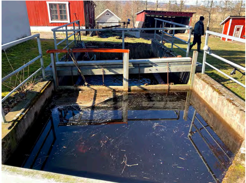
Figur 4. Betongutskov i slutet av intagskanalen.
