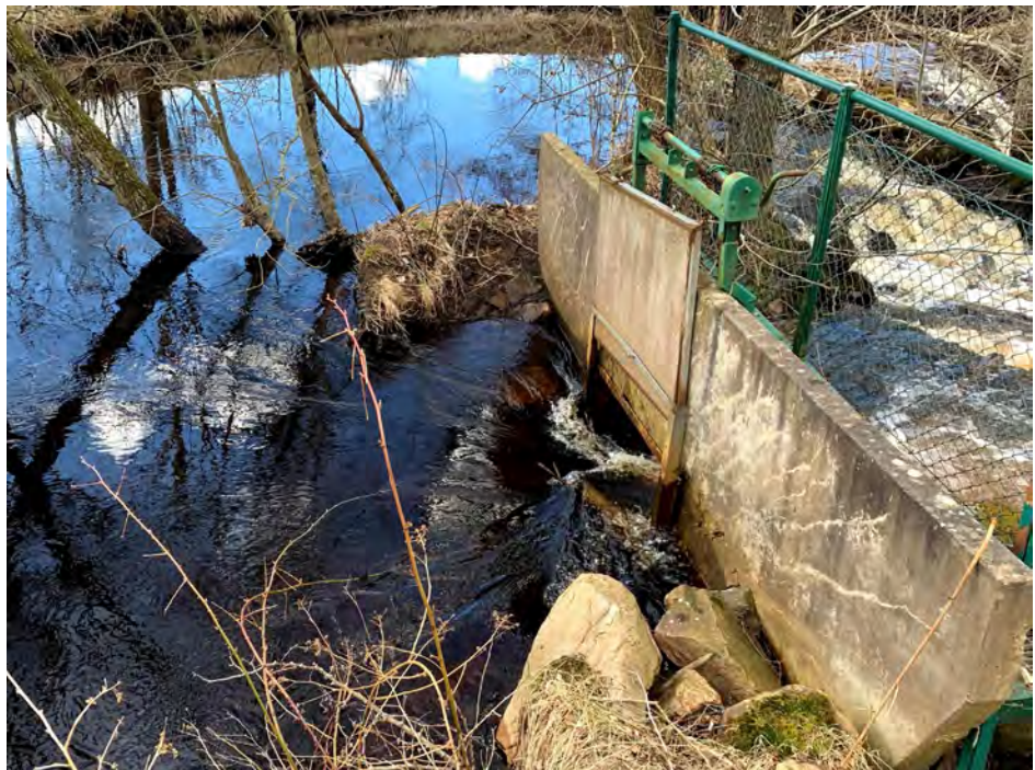
Figur 3. Utskov med rektangulär öppning och avstängningslucka.
