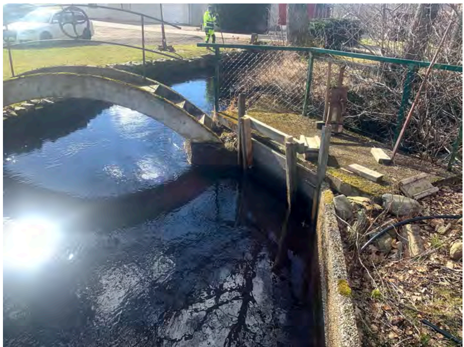
Figur 5. Flodutskov i intagskanalen, ca 30 m uppströms betongutskovet.
