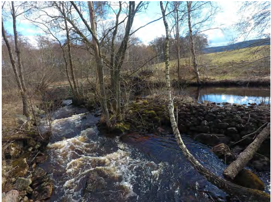
Figur 2. Naturfåran, till vänster i bild, skiljs från intagskanalen av en ca 30 m lång stendamm.
