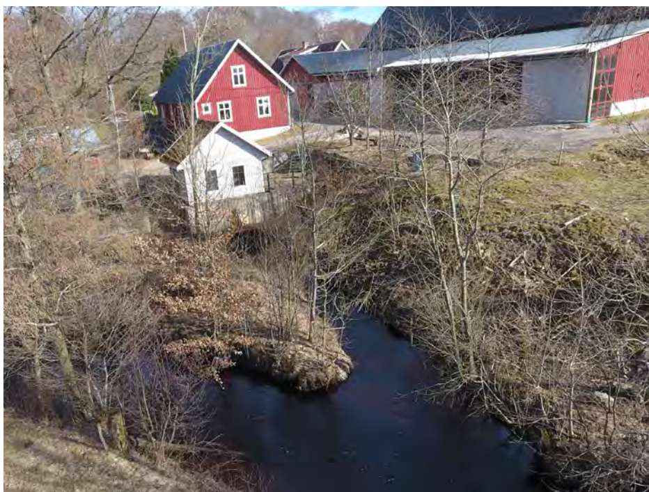
Figur 6. Från turbinhuset (vit byggnad) leds vattnet tillbaka till naturfåran (t.v.) via en 20 m lång utloppskanal (t.h.).
