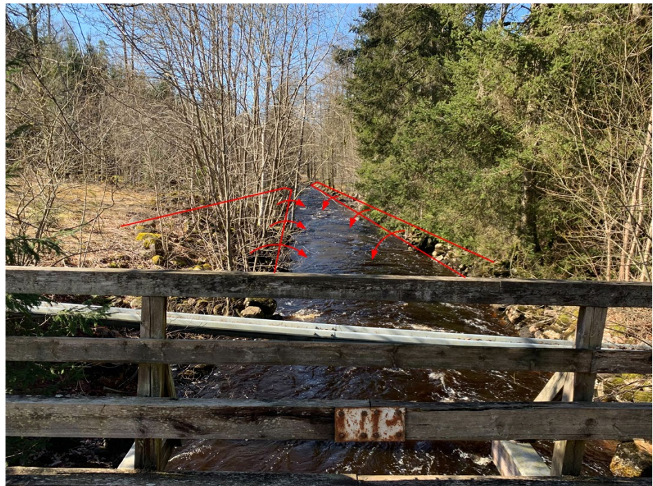
Figur 7. Rensmaterial i form av block och sten återförs till åfåran.
