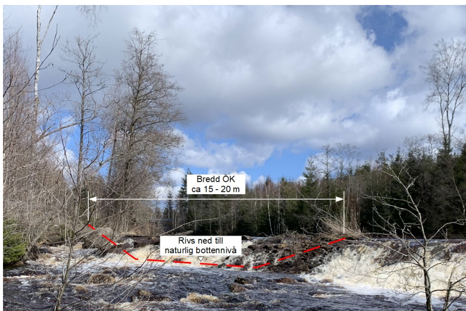
Figur 5. Del av dammvallen rivs och ersätts med en naturliknande tröskel.
