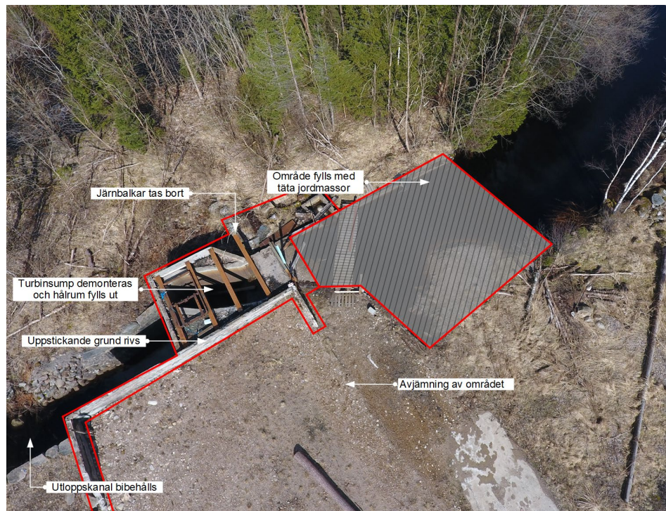
Figur 6. Kraftstationen rivs och området fylls igen.
