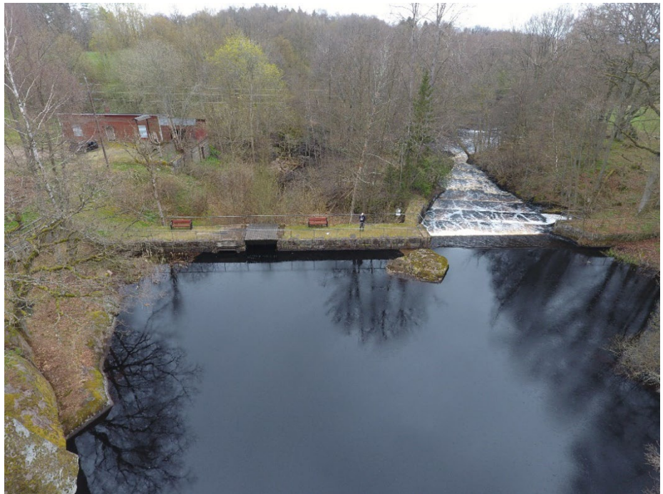
Figur 03. Dammbyggnad i huggen sten (vänster) och skibordsöverfall (höger). Nedströms vy.
