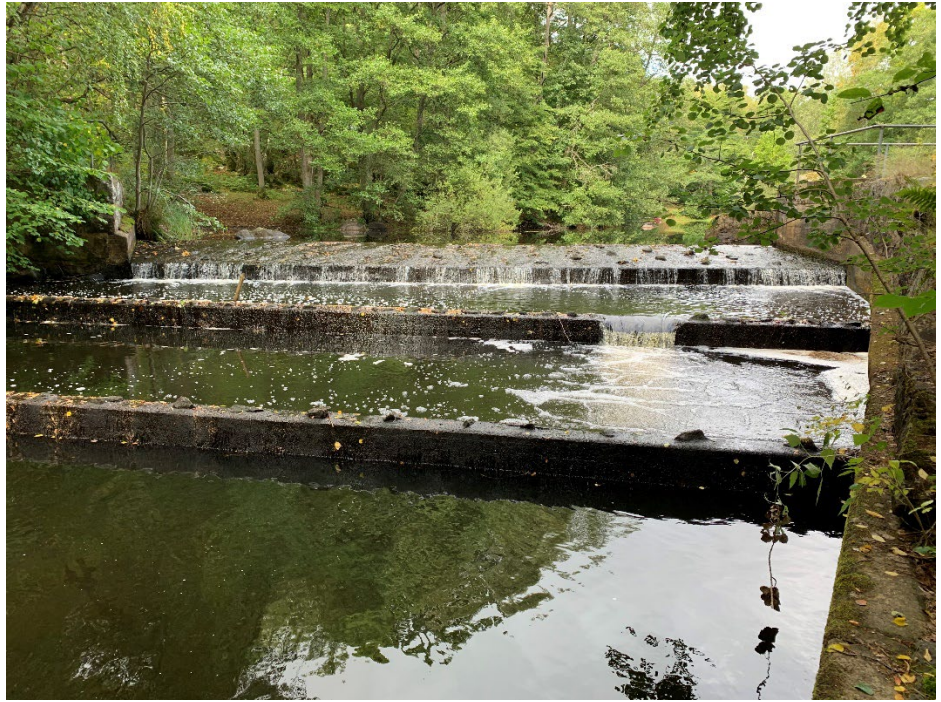
Figur 04. Gjutna betongtrappor nedan skibordsöverfallet sett från åns vänstra sida.
