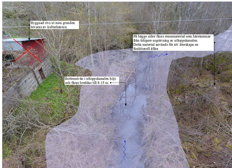
Figur 08. Illustration över planerade åtgärder och framtida vattenutbredning i utloppskanalen. Nedströmsvy.
