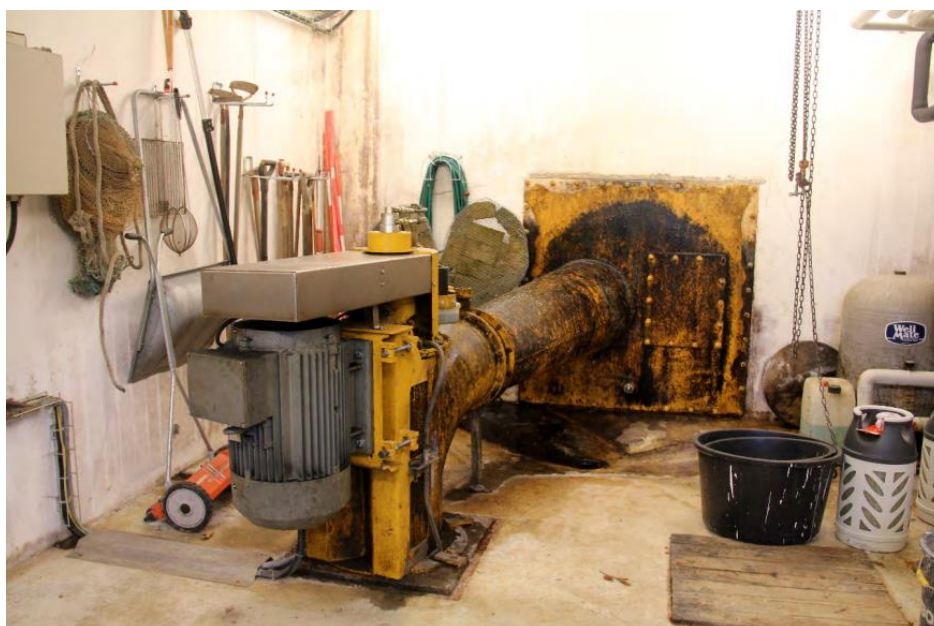
Figur 6. Kraftstationen försedd med semikaplanturbin.
