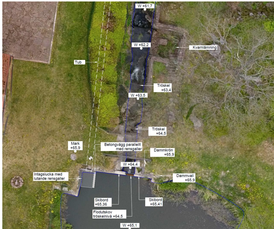
Figur 3. Dammbyggnad med intag, flodutskov och skibordsöverfall i Kvarndammen.
