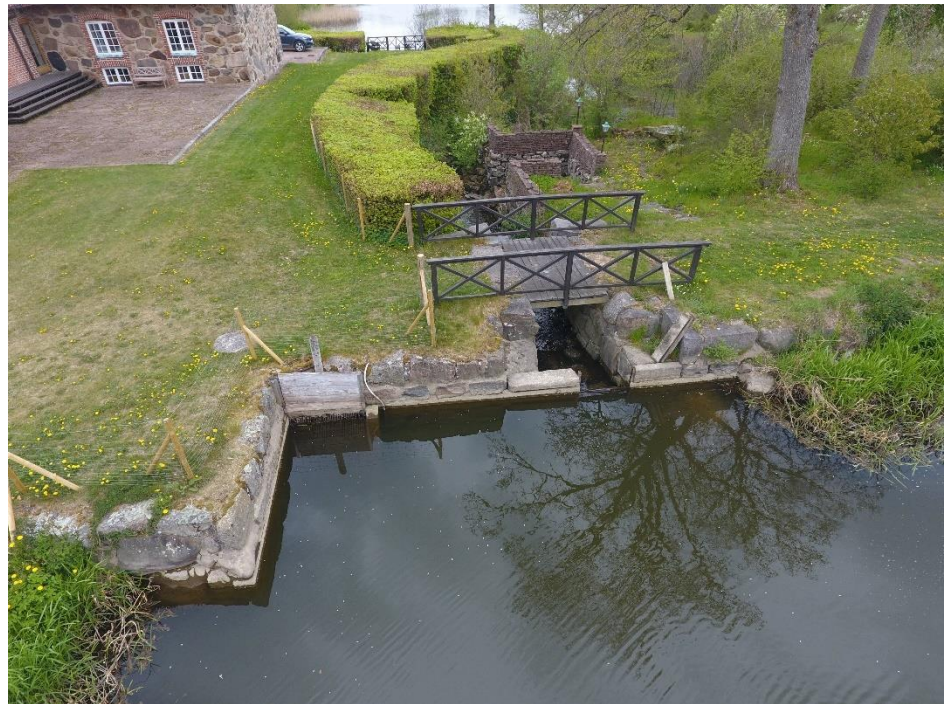
Figur 4. Kvarndammen sett från uppströmssidan. Från vänster till höger i bild: intag, dammvall, skibord, flodutskov, skibord och dammvall.
