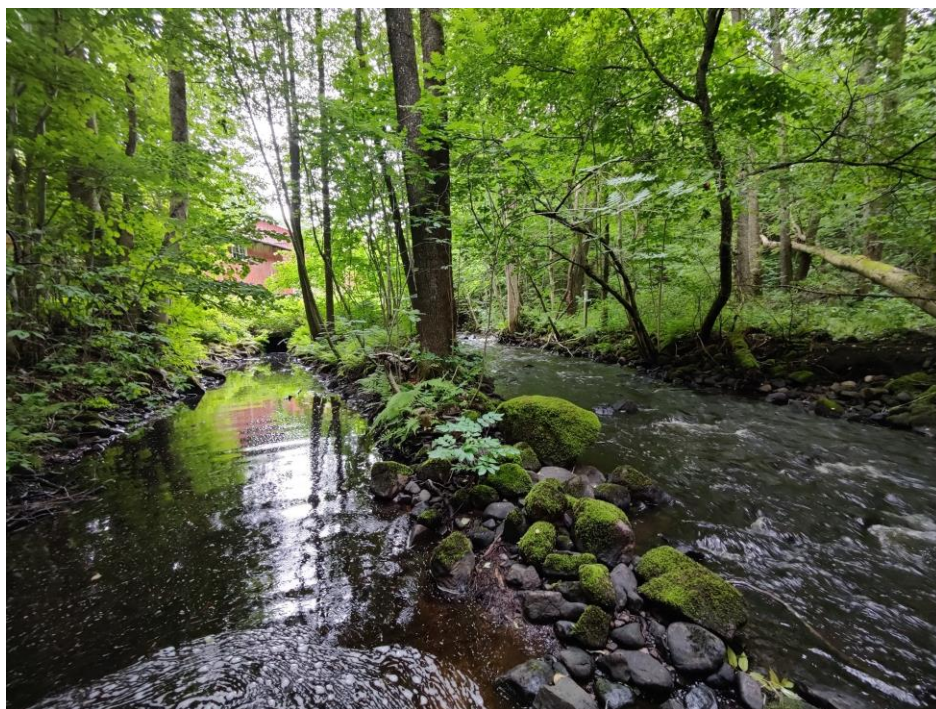
Figur 6. Utloppskanalen (t.v. i bild) skiljs från naturfåran utav en ledarm av lavad sten.
