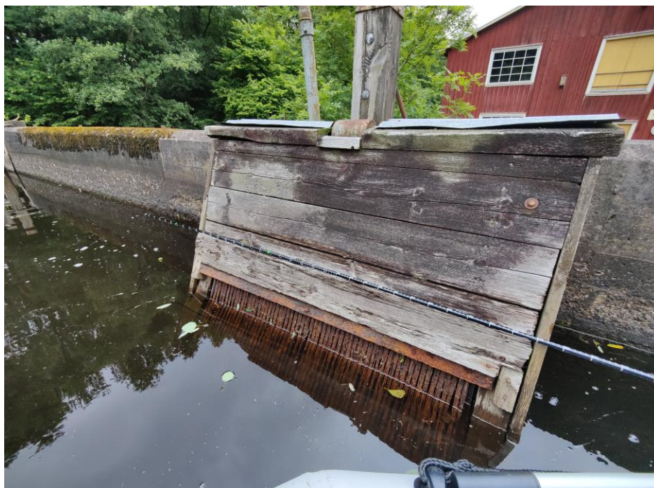
Figur 4. Avstängt intag till turbinen som en gång i tiden producerade kraft på platsen.
