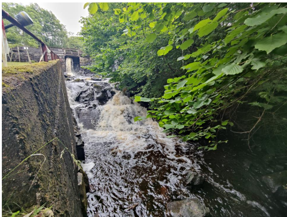
Figur 7. Vattenfall direkt nedströms dammvallen vid Okome kvarn.
