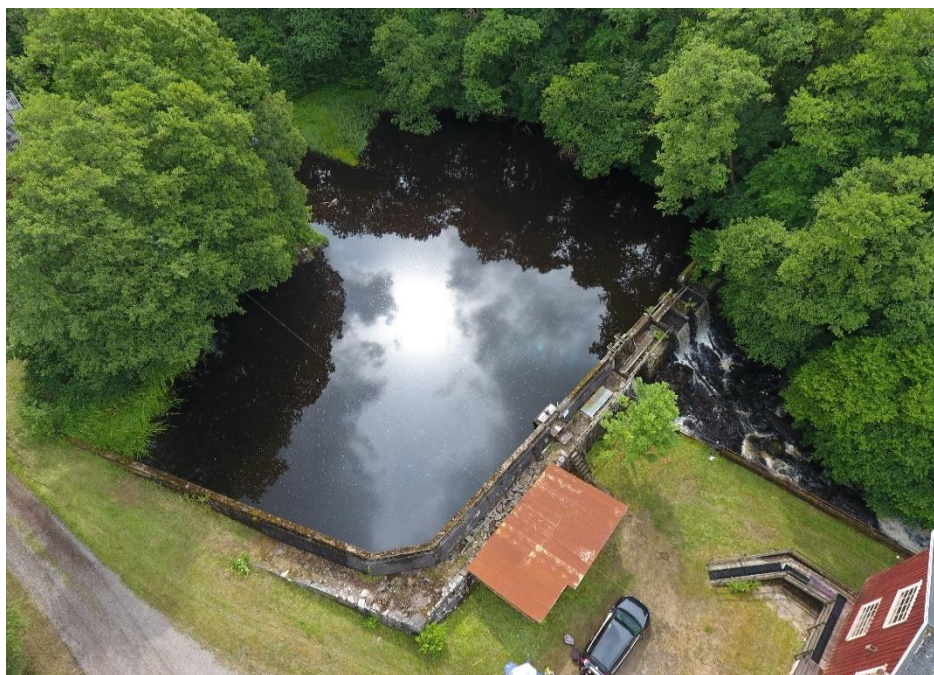
Figur 3. Den ursprungliga dammvallen av lavad sten syns tydligt bakom den betongförestärkta uppströmssidan.
