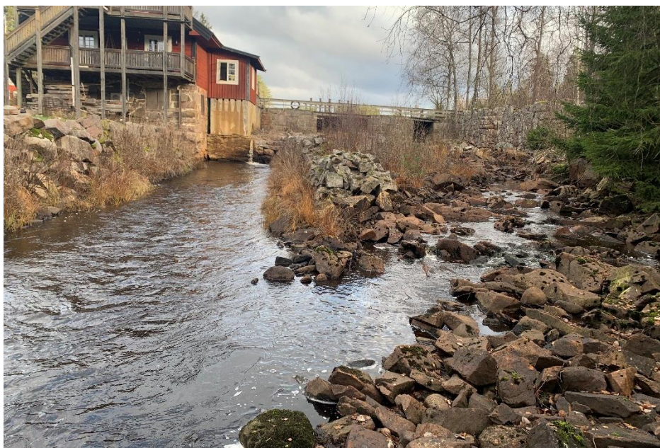
Figur 9. Naturfåran och utloppskanalen sammanfogas ca 50 m nedströms dammanläggningen.
