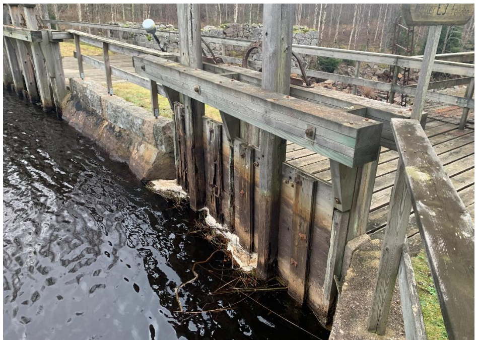
Figur 6. Intaget är utrustat med två spetluckor, nedströmsvy.
