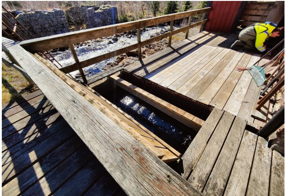
Figur 7. Från intaget leds vattnet via en betongkanal till turbinsumpen där en francisturbin är installerad, nedströmsvy.
