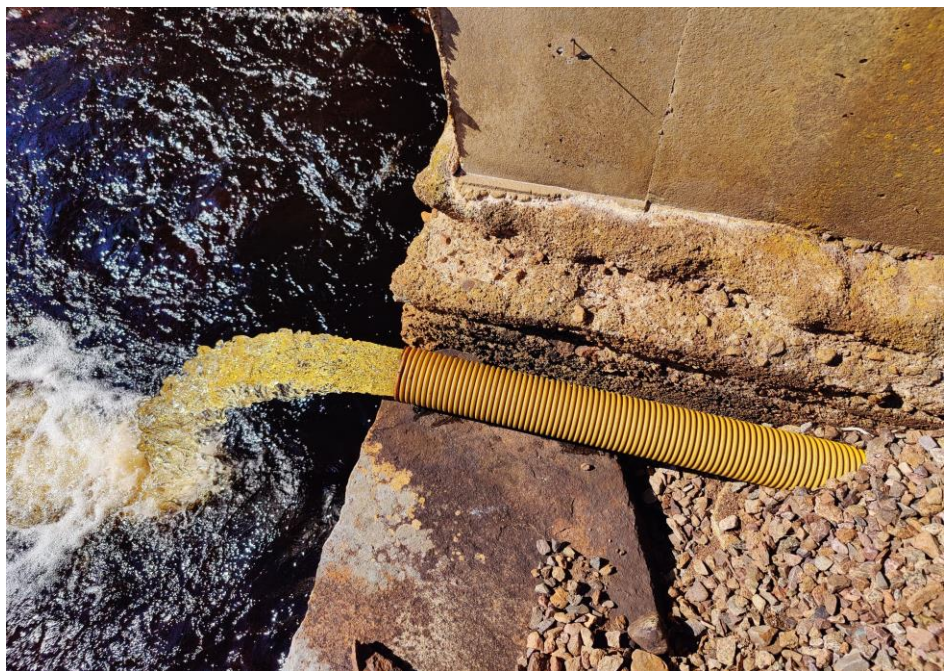
Figur 8. Flyktröret utgörs av ett korrugerat plaströr.
