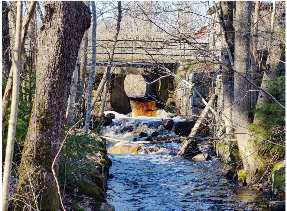
Figur 5. Uppströmsvy över den vänstra kulverten vid Belganet Mellan. Vattenföring ca 3,8 m 3 /s.
