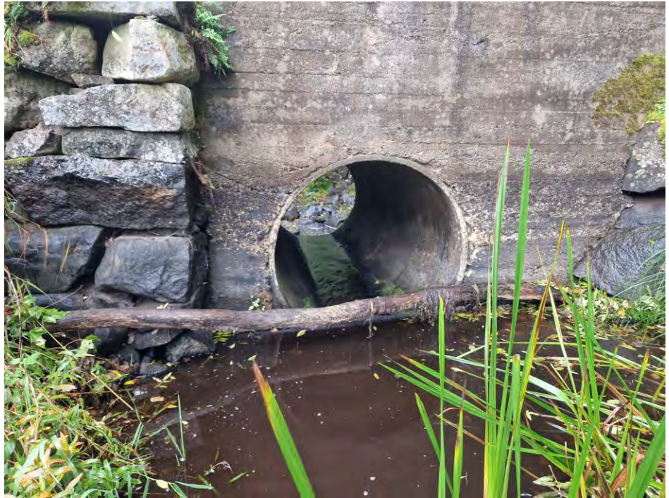
Figur 7. Nedströmsvy över den högra kulverten. Vattenföring ca 0,3 m 3 /s.
