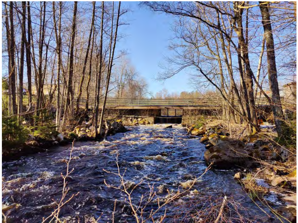
Figur 8. Uppströmsvy över naturfåran från ca 30 m nedströms bron. Vattenföring ca 3,8 m 3 /s.
