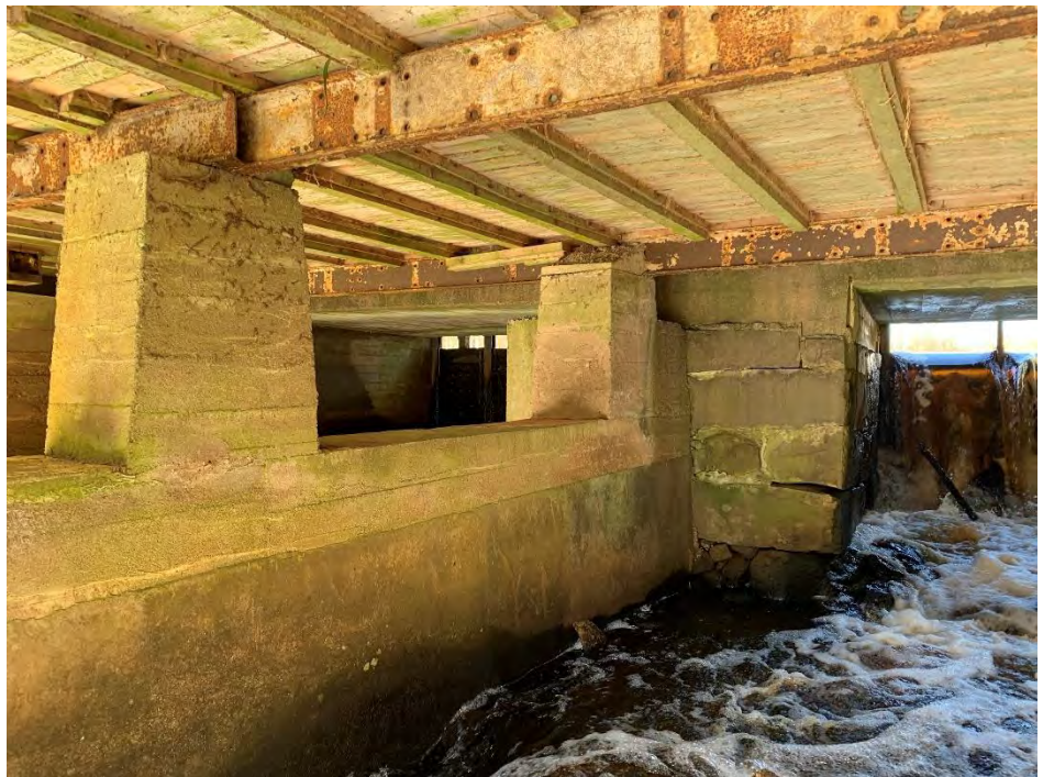
Figur 4. Betongfundament skiljer sättutskov från flodutskov.
