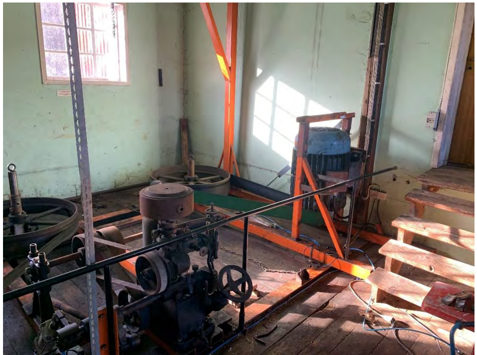
Figur 6. Turbinerna är av typen francis och har total slukförmåga på ca 2,5 m 3 /s.
