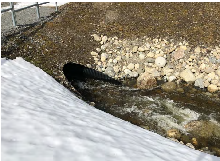
Figur 14. Exempelbild på kulvert under väg vid ett omlöp i Billstaån, Indalsälven.
