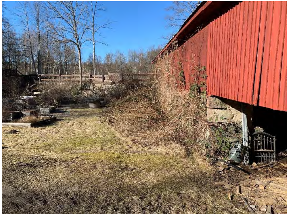
Figur 8. Röd byggnad är ett sågverk som tidigare drevs av vattenkraft. Dess utloppskanal låg intill huskroppen där sly växer.
