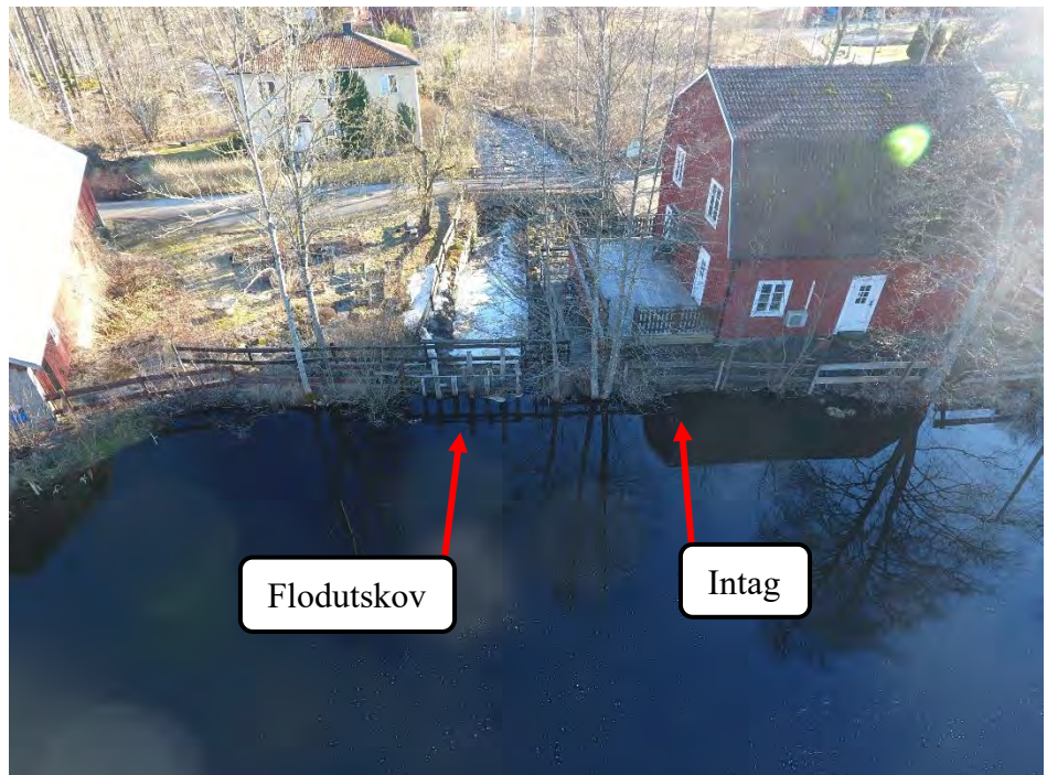
Figur 5. Nedströmsvy över Knällsberg kraftverk och dess vattenvägar.
