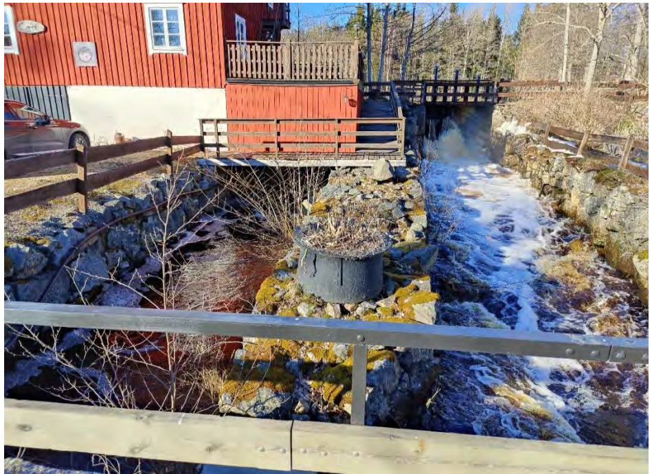
Figur 4. Utloppskanalen, till vänster, skiljs från huvudfåran, till höger, utav enstensatt ledarm.
