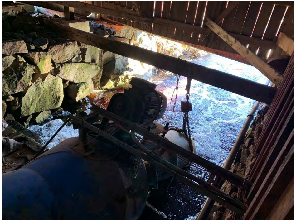
Figur 6. Turbinen vid Knällsbergs kraftverk är av typen kaplan.
