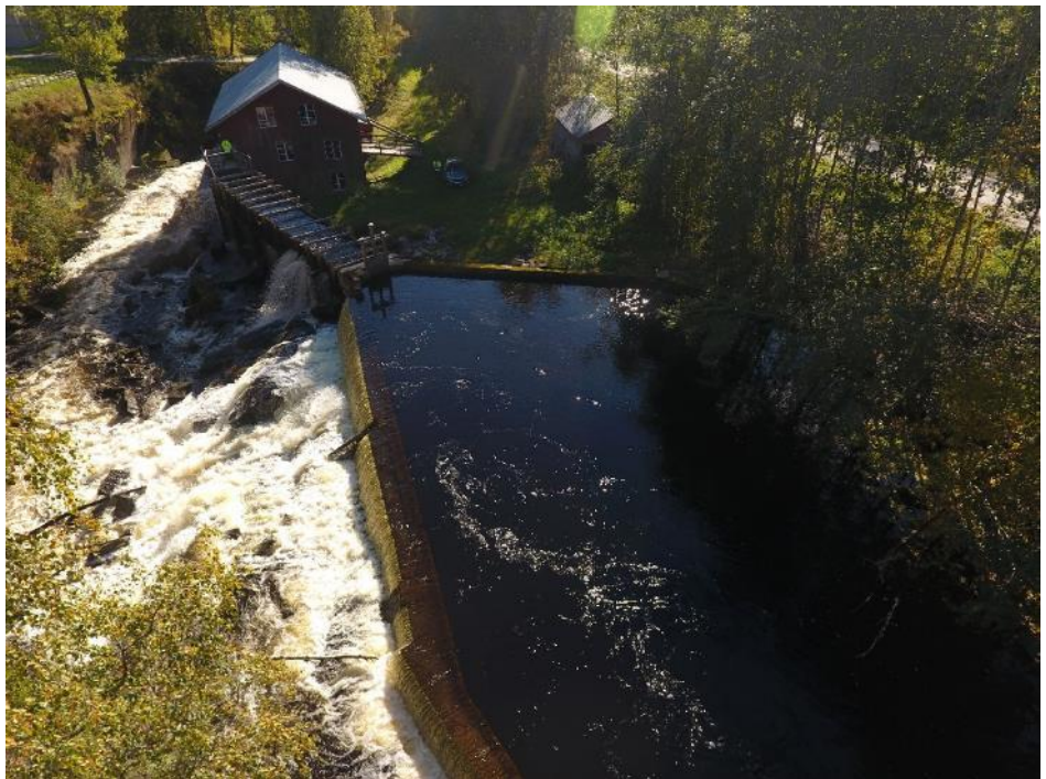
Figur 6. Nedströmsvy över dammen, intag och kraftverk.
