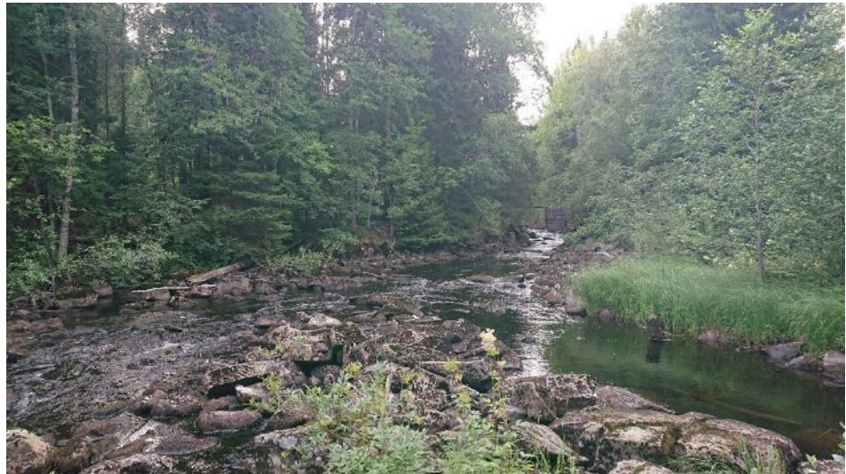
Figur 4. Delning av åfåran uppströms övre dammbyggnaden. Vy uppströms. Vänster sida i bild utgör kraftverksgrenen. Foto taget 2022-07-22 vid låg vattenföring (ca 0,5 m 3 /s).
