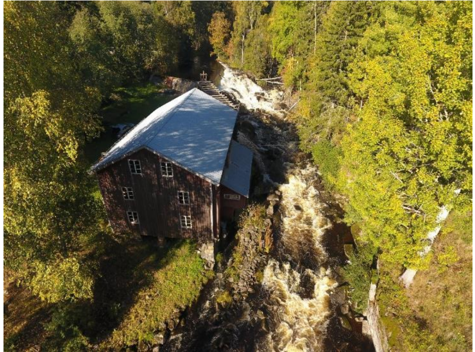
Figur 8. Uppströmsvy över anläggningen. Utloppskanalen ses nerst i bild och naturfåran till höger i bild.
