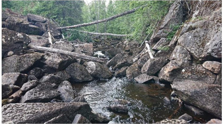
Figur 9. Ett parti av naturfåran nedströms skibordets som utgör ett vandringshinder vid låga vattenföringar. Foto taget 2022-07-22 vid låg vattenföring.
