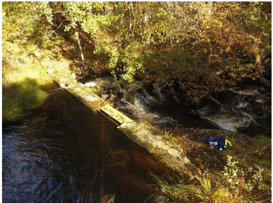
Figur 3. Övre dammen med sättutskov till höger och fiskvägskov till vänster.
