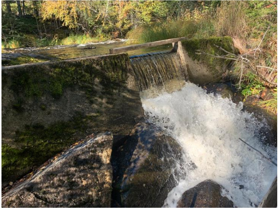
Figur 5. Utskov i betong mellan intagskanal och naturfåra.
