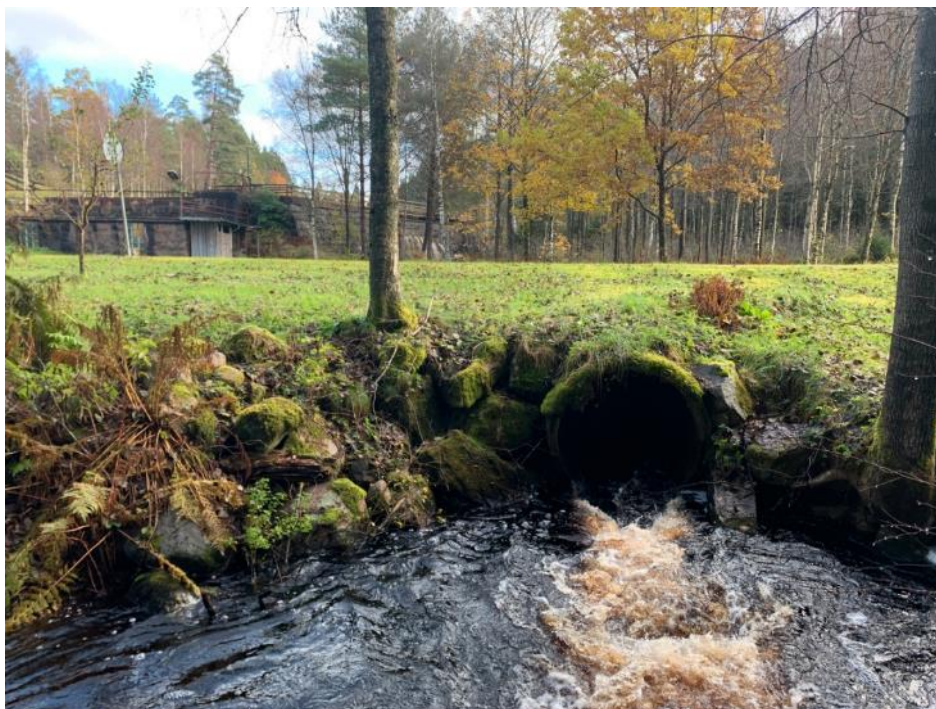
Figur 22. Nedströms mynning kulvert, naturfåra
