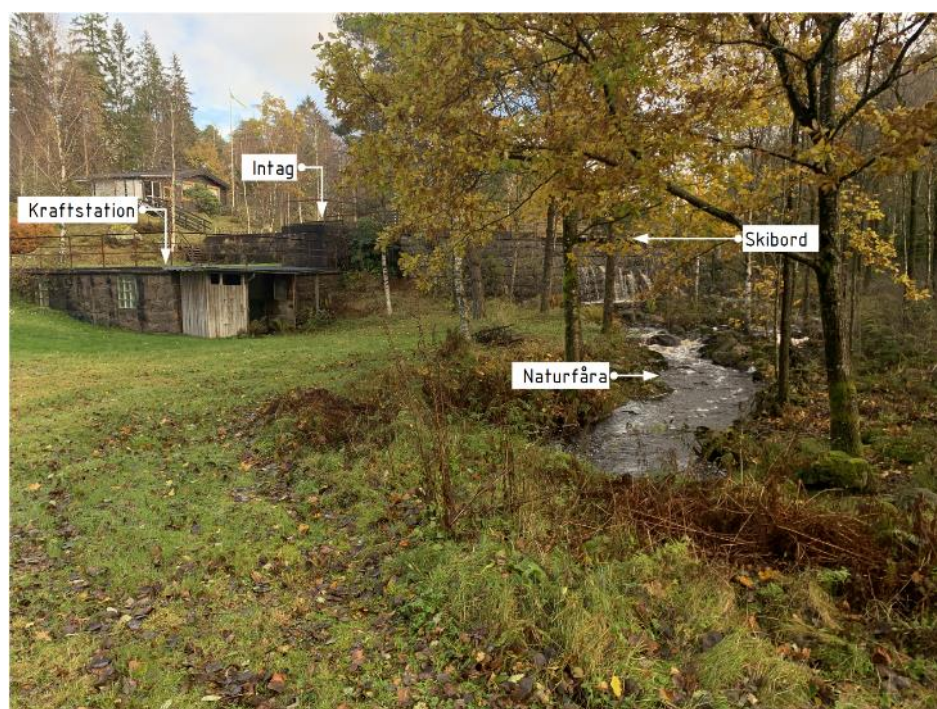
Figur 11. Uppströmsvy över naturfåra, skalmursdamm och kraftstation
