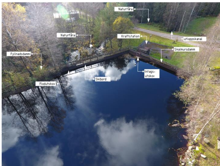
Figur 3. Skalmursdammen med skibord, intag och kraftstation. Till vänster syns anslutning mot fyllnadsdammen, bakom syns naturfåran
