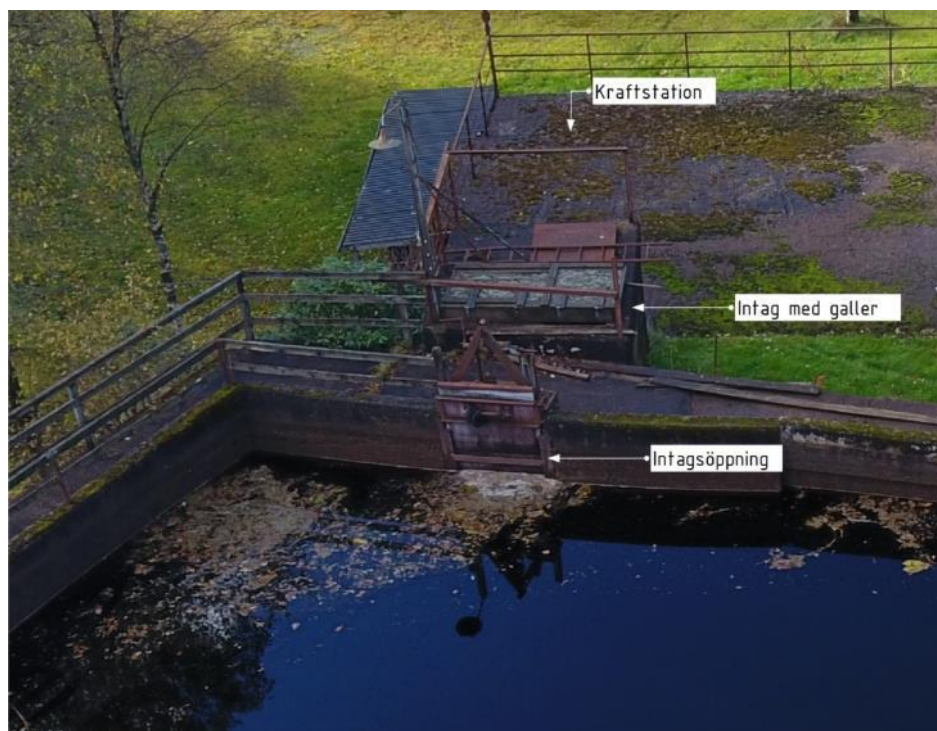
Figur 10. Intag och kraftstation
