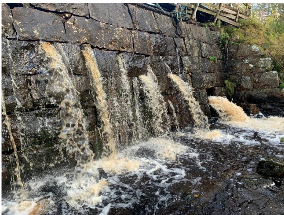
Figur 8. Läckage genom dammen under skibordet. Längst till höger utlopp från flodutskov
