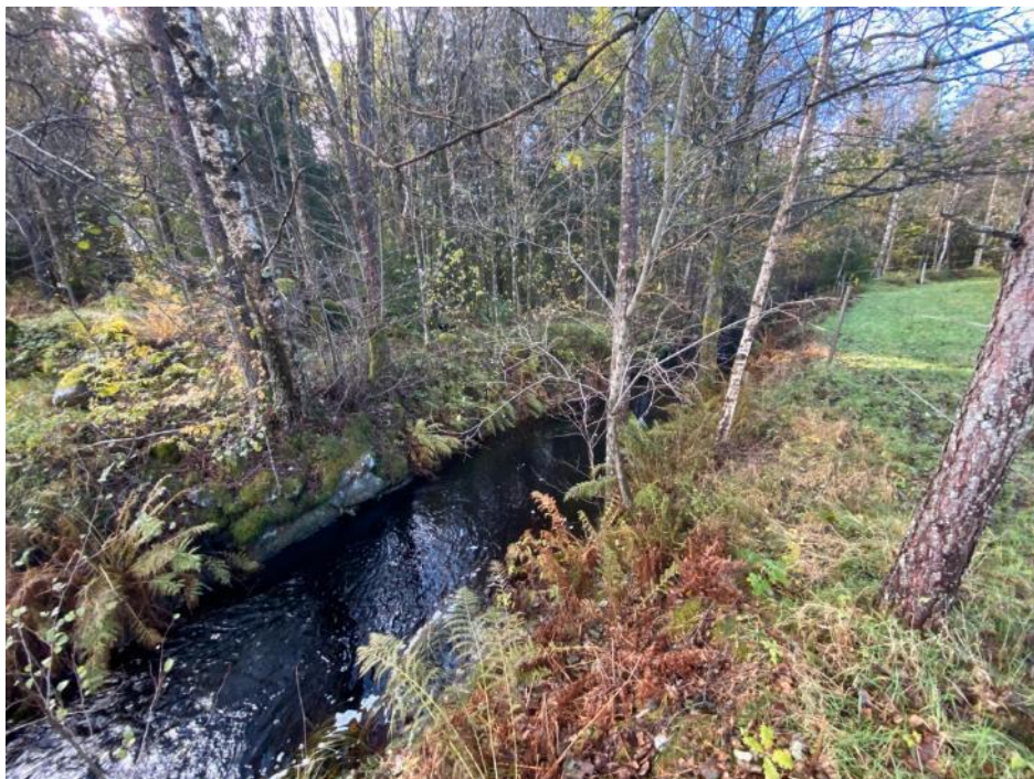
Figur 12. Utloppskanal nedströms kulvert från kraftstation
