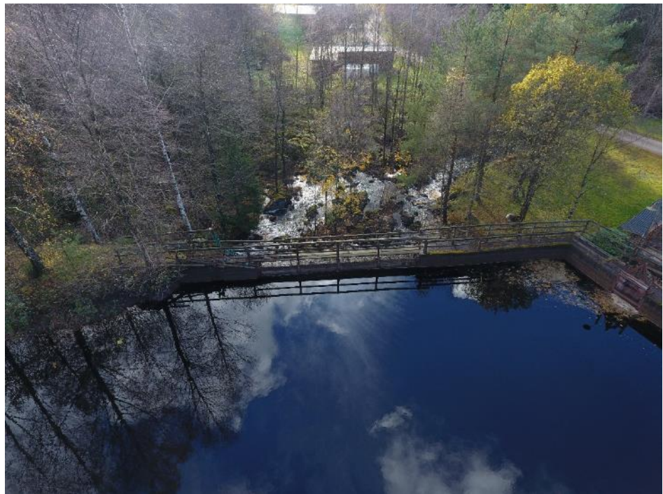
Figur 9. Vänster del av skalmursdammen med skibord, träsättar och flodutskov
