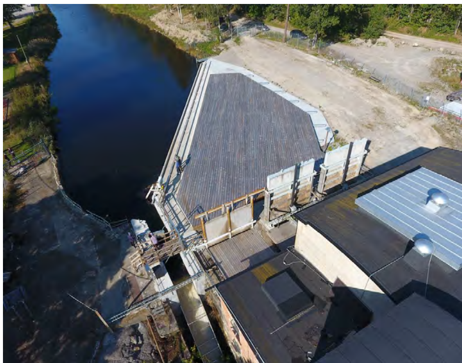
Figur 18. Serviceytan mellan galler och intaget på Fridafors nedre kraftverk.
