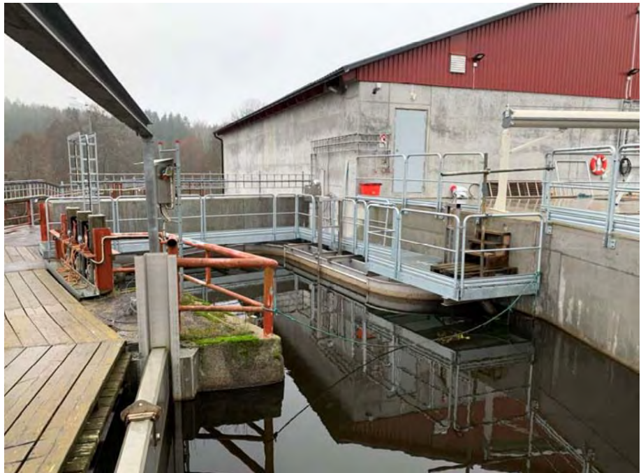
Figur 4. Kraftstation och flykträna. Fotograferat från dammkrönet mot mellanrummet mellan vänster intag och den del av dammen som löper parallellt med strömriktningen.
