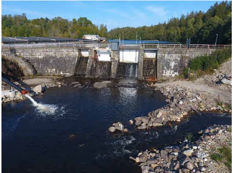
Figur 9. Fiskvägens mynning till höger i bild. Till vänster i bild syns flyktvägens mynning och i mitten dammbyggnaden med flodutskoven.
