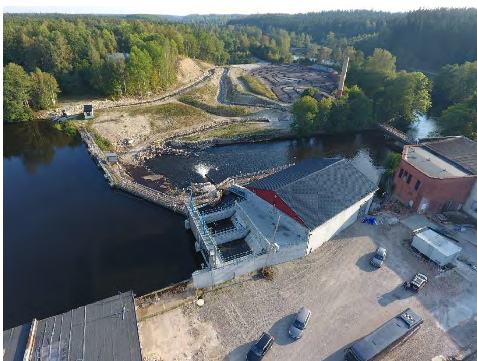
Figur 2. Flygfoto över Fridafors Övre Kraftverk. Intag och kraftstation mitt i bilden på åns högra strand. Dammbyggnaden går tvärs över ån och omlöpet syns på den vänstra stranden.
