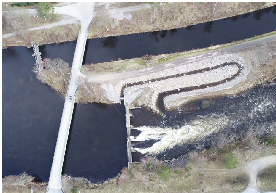
Figur 11. Flygfoto över dammbyggnad och fiskväg vid Fridafors nedre. Överst i bild syns intagskanalen.
