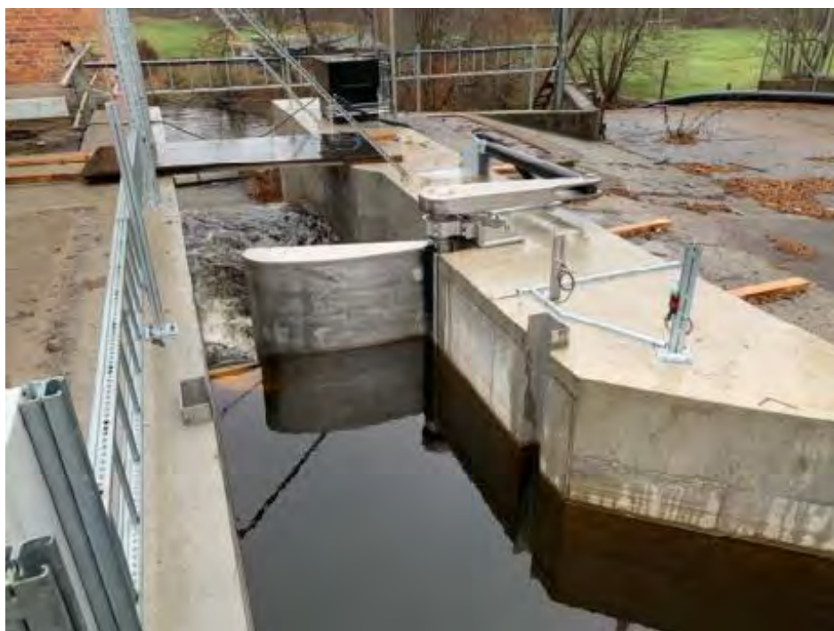
Figur 19. Klafflucka vid flyktvägen och bakomliggande flykträdda
