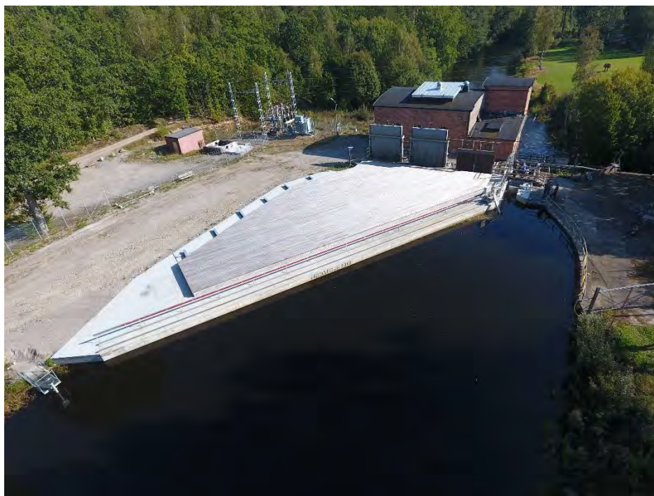
Figur 16. Nedströmsvy över Fridafors Nedre kraftverk.
