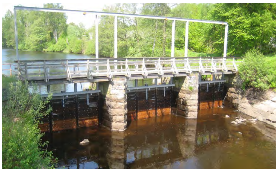
Figur 14. Avstängningsluckor i intagskanalen, fotograferat i samband med torrläggning av intagskanalen.
