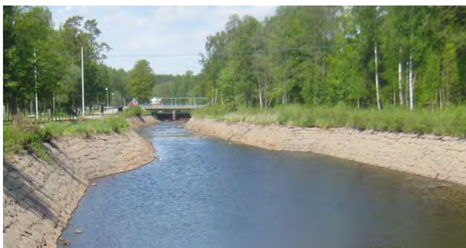
Figur 15. Uppströmsvy över intagskanalen.
