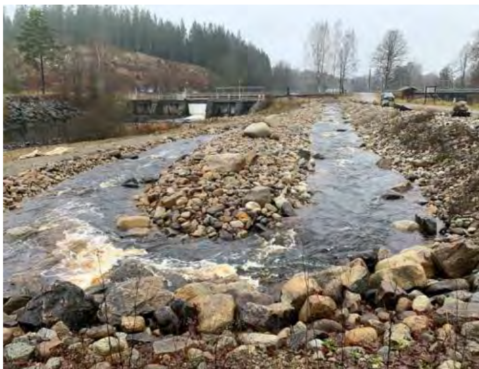
Figur 24. Omlöpet sett mot dammbyggnaden.
