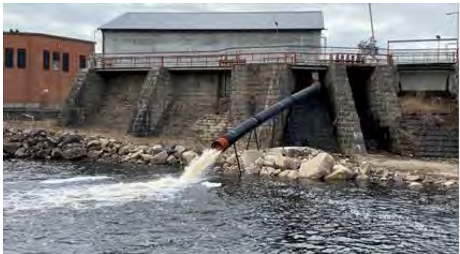
Figur 5. Flyktrännans utlopp nedströms dammen. I bakgrunden syns kraftstationen.
