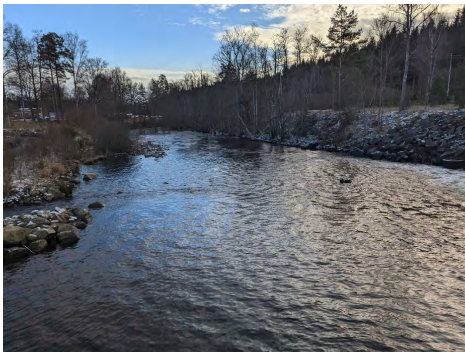
Figur 29. Nedströmsvy mot naturfåran från dammbyggnaden.
