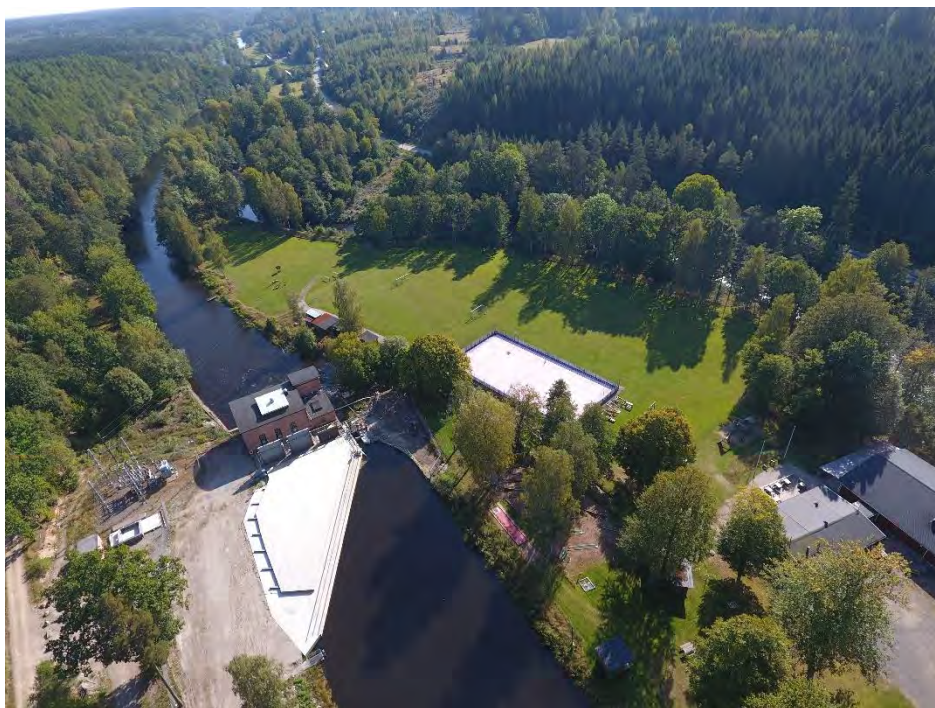
Figur 22. Flygfoto över Fridafors Nedre kraftstation och utloppskanal. Nedströmsvy.
