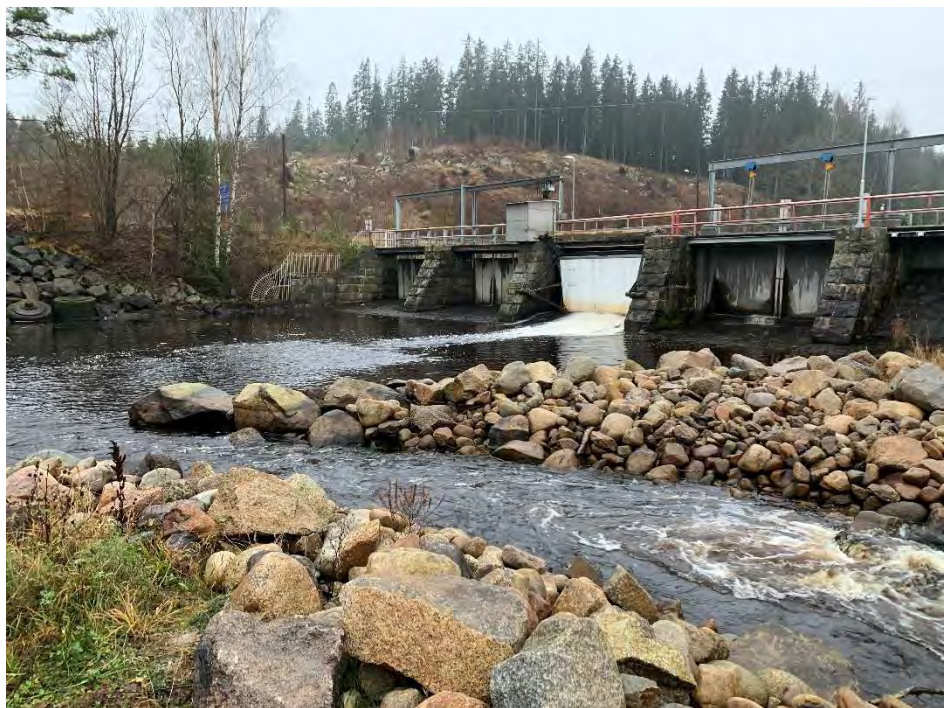
Figur 13. Dammbbyggnaden sett från nedströmssidan. I förgrunden syns omlöpets mynning.
