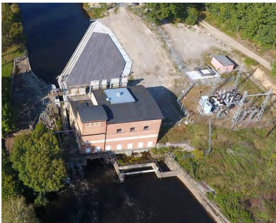
Figur 21. Flygfoto över Fridafors Nedre kraftstation.
