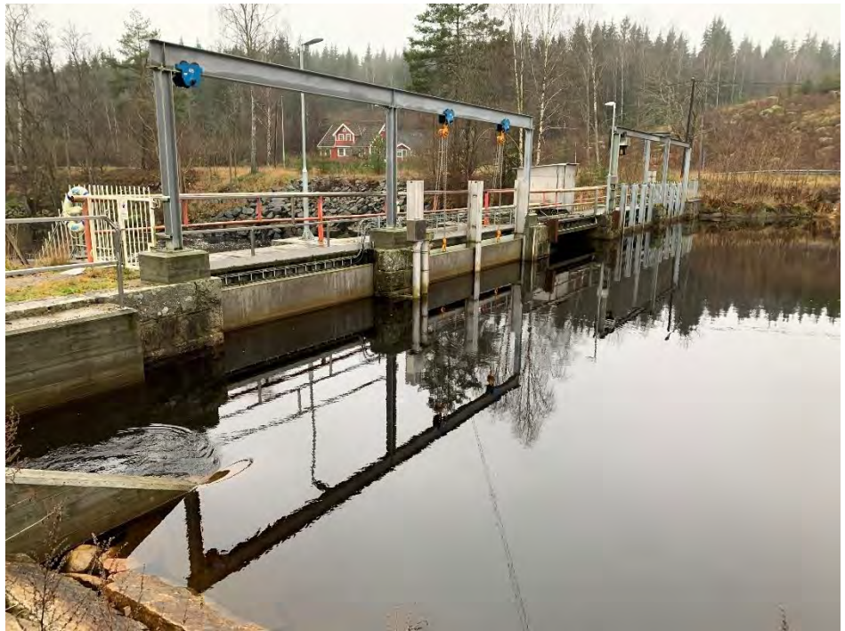
Figur 12. Dammbbyggnaden vid Fridafors Nedre sett från vänster strand.
