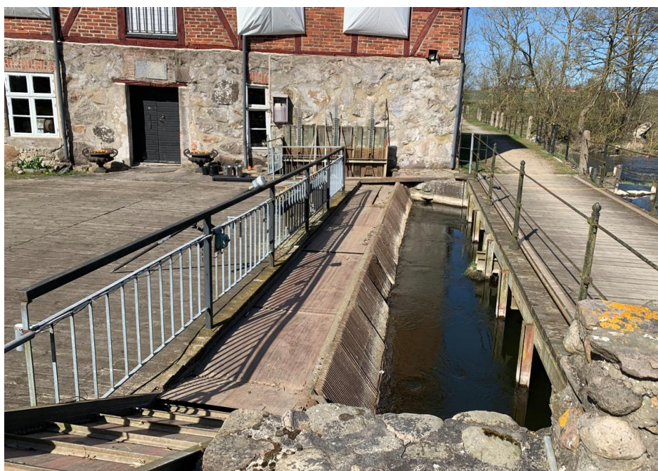
Figur 7. Vy från höger strand. Intaget är utrustat med rensgaller. Framför respektive turbins intag nedströms gallret finns avstängningsluckor.
