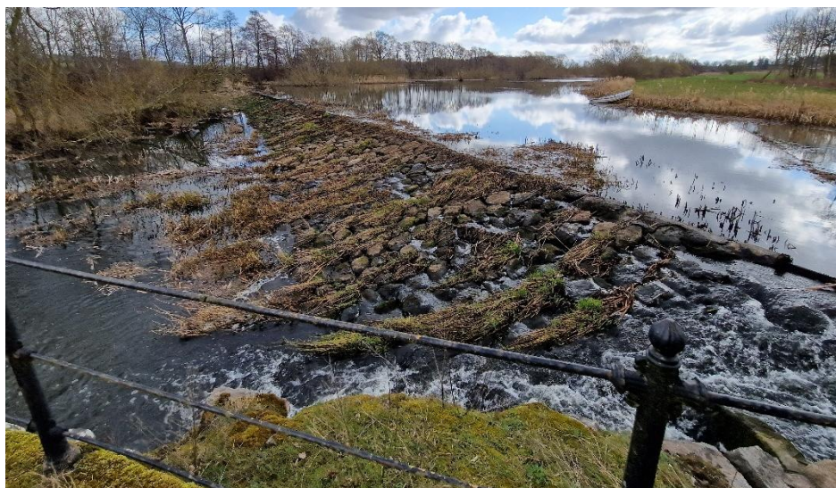
Figur 4. Uppströmsvy över överfallsdammen, starksimmande arter kan passera över dammen när överströmningen är stor.
