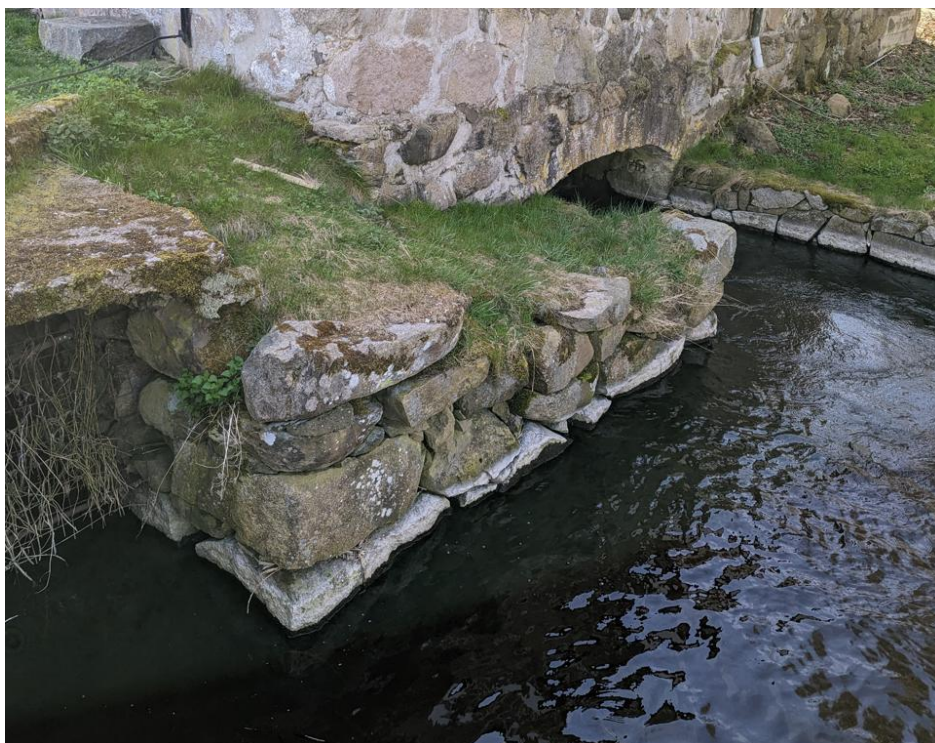
Figur 8. Nedströmsvy från bron över utloppskanal från G1, t.v. i bild syns även utloppet från f.d. ålkista.
