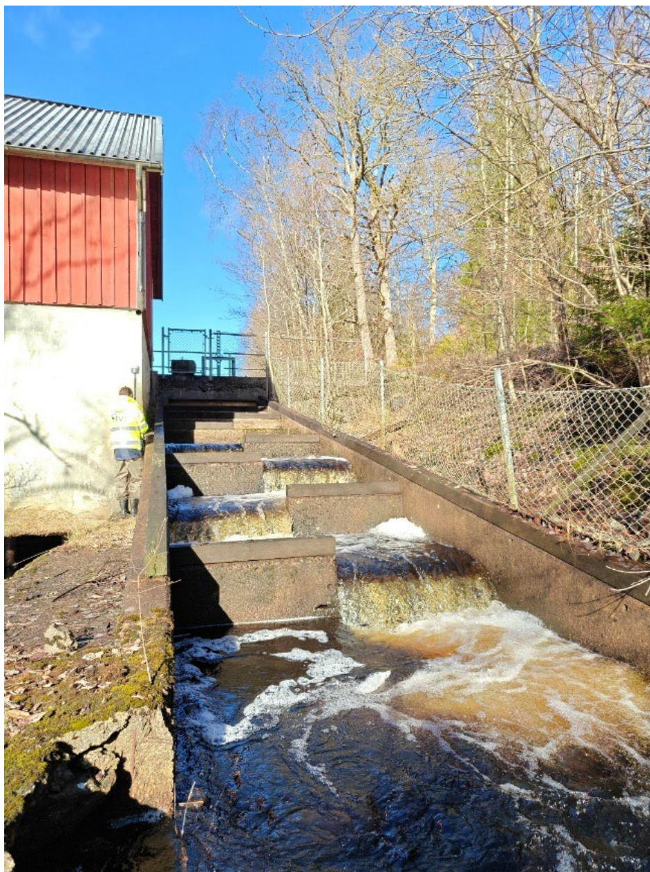
Figur 7. Bassängtrappan på kraftverkets vänstra sida.
