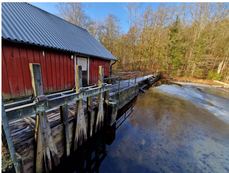
Figur 4. Intaget till kraftverket är permanent avstängt.
