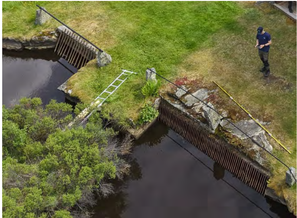
Figur 8. Intagsgaller till höger i bild. Till vänster syns kanalen som leder till flodutskovet som även det är försett med grovgaller. Utskov i mittvallen syns mitt i bilden och förbinder intag och flodutskov med varandra.
