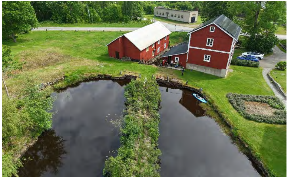
Figur 3. På höger sida om mittvallen finns intag som leder till kraftstationen samt skibord. På vänster sida leder en kanal till flodutskovet.
