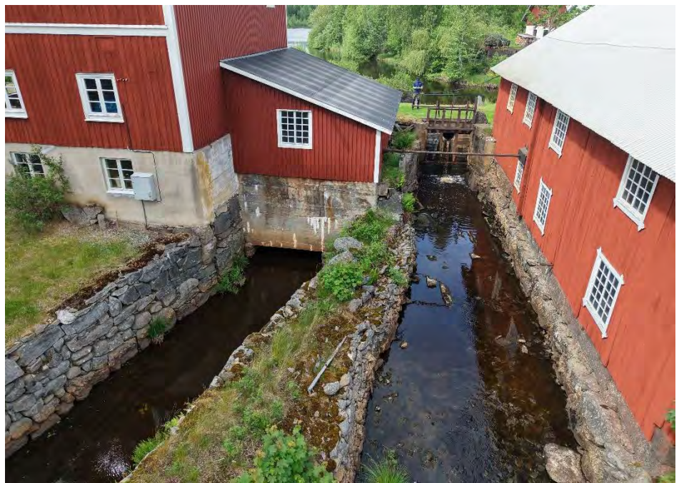
Figur 4. Till höger i bild syns flodutskov och avtappningskanal från flodutskovet. Till vänster i bild syns kraftstationsbyggnad och utloppskanal.
