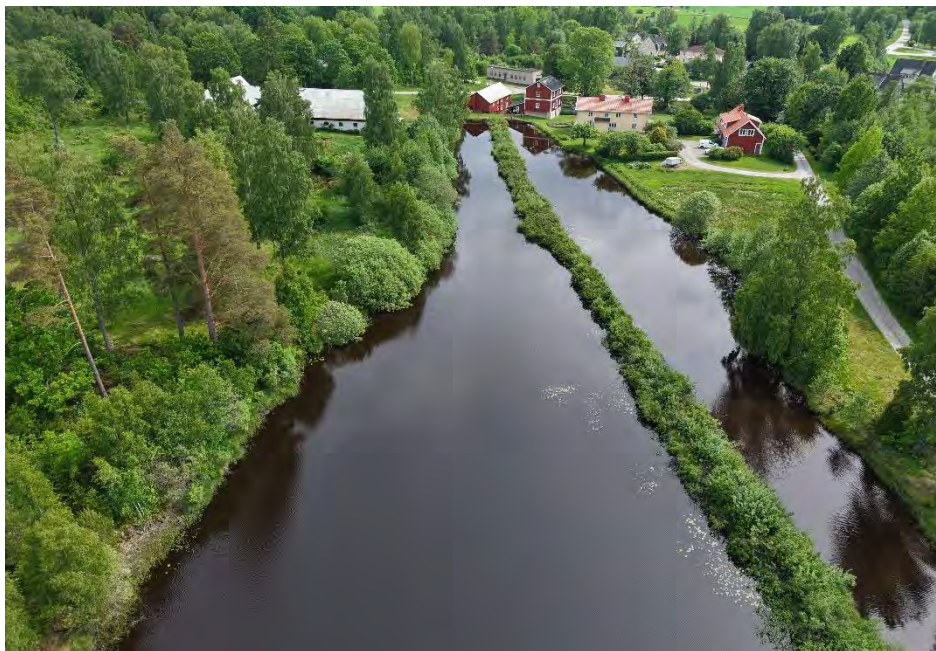
Figur 5. Äldre dammvall som separerar magasinet. Damm och kraftverk syns i bakgrund.
