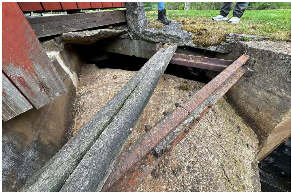
Figur 9. Skibordsöverfall, ca 2,6 m brett med medelkrönnivå +159,26. Vy i uppströms riktning. Flodutskov till höger om bilden och kraftstation till vänster om bilden.
