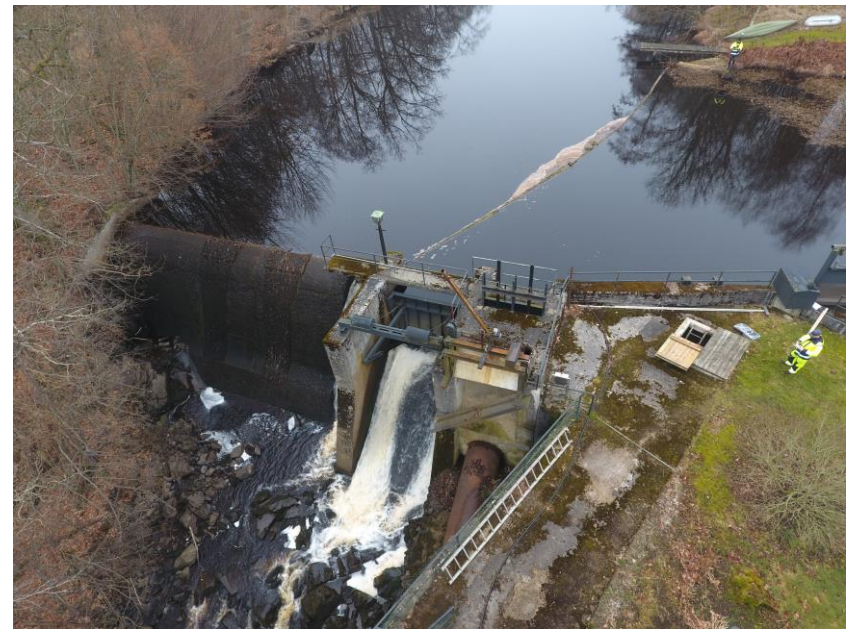
Figur 2. Dammanläggning sett från nedströmssidan.
