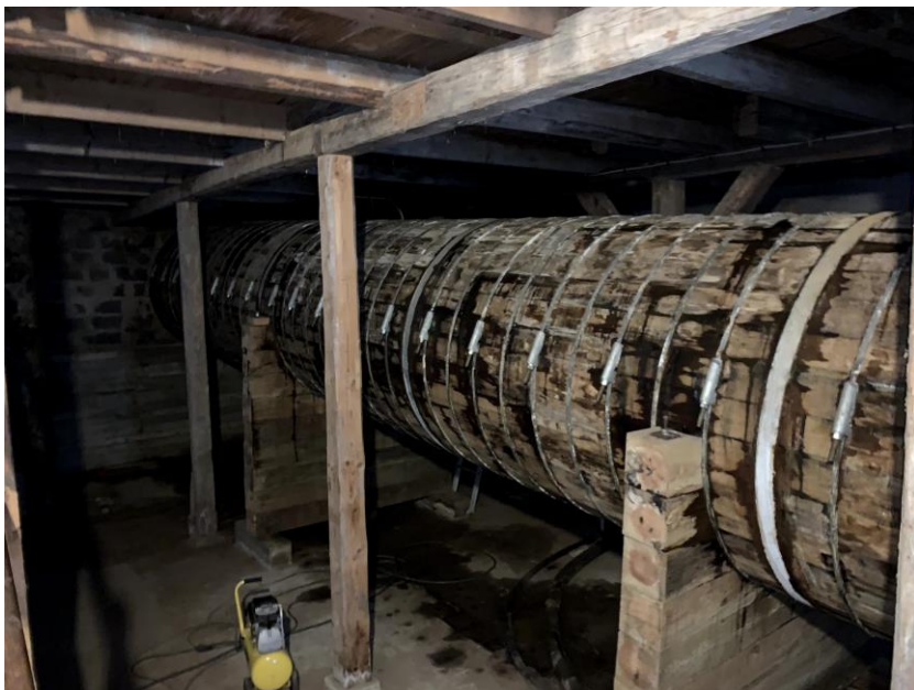
Figur 5. Intagstuben till den nya kraftstationen passerar genom den västra kvarnbyggnaden.
