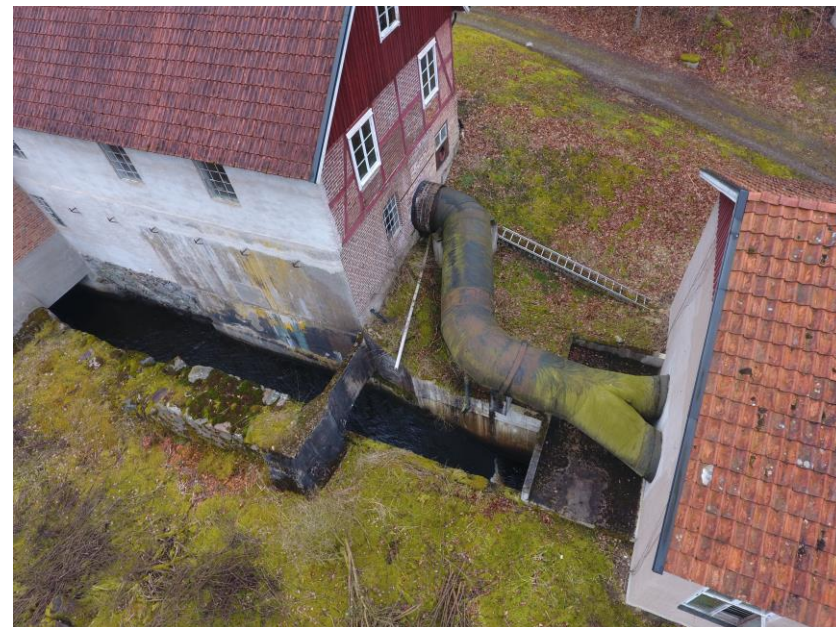
Figur 6. Äldre kraftstations utloppskanal passerar in under den nya kraftstationen. Nedersta del av ny intagstub.
