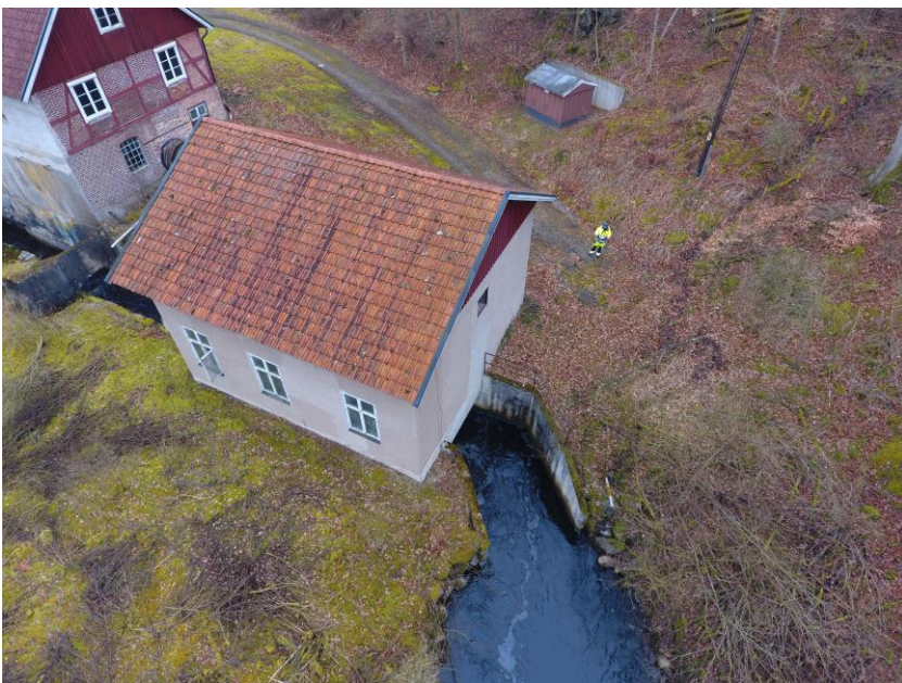
Figur 7. Nytt turbinhus samt utloppskanal.
