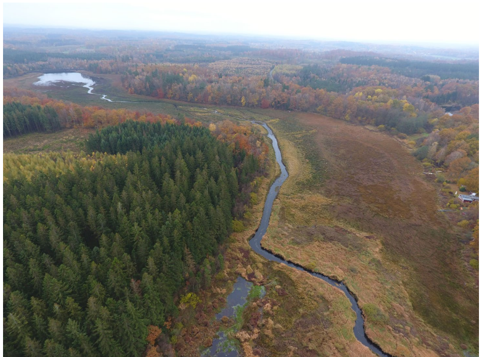
Figur 7. Översiktsfoto över det tidigare dämningpåverkade området. Till vänster syns den avsänkta kraftverksdammen och till höger ses fritidshus i området Tostarp. Vy nedströms
