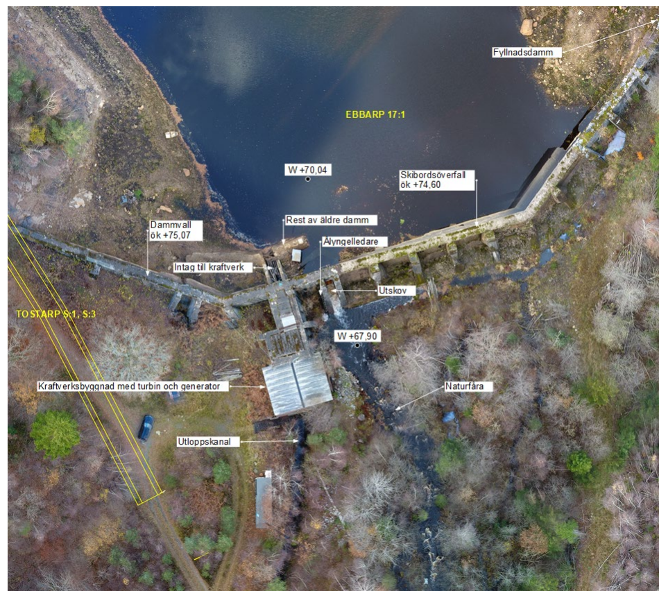
Figur 2. Översikt över kraftverksdammen.
