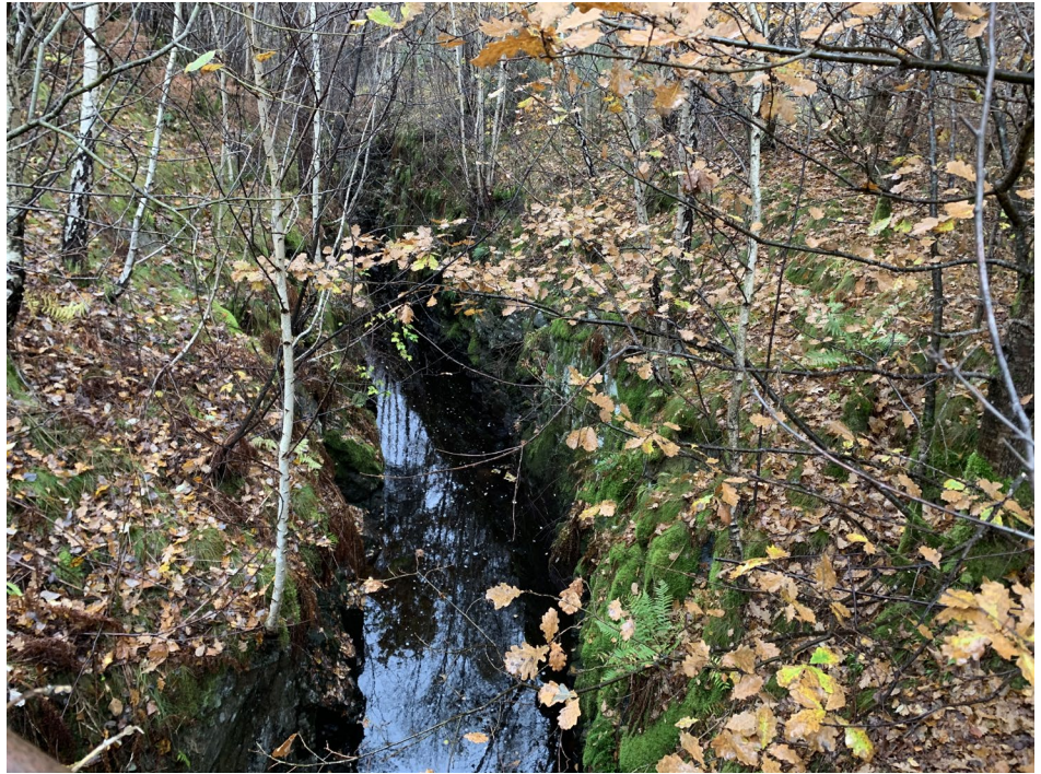
Figur 6. Nedströms kraftverket följer en 330 m lång utloppskanal som är nedsprängd i berggrunden. Vy uppströms.
