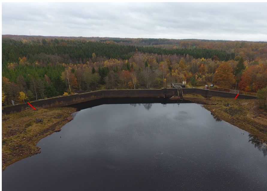
Figur 9. Illustration över vilka delar av dammen som kommer att avlägsnas. Betongdammen mellan de röda strecken avses att rivas ut.
