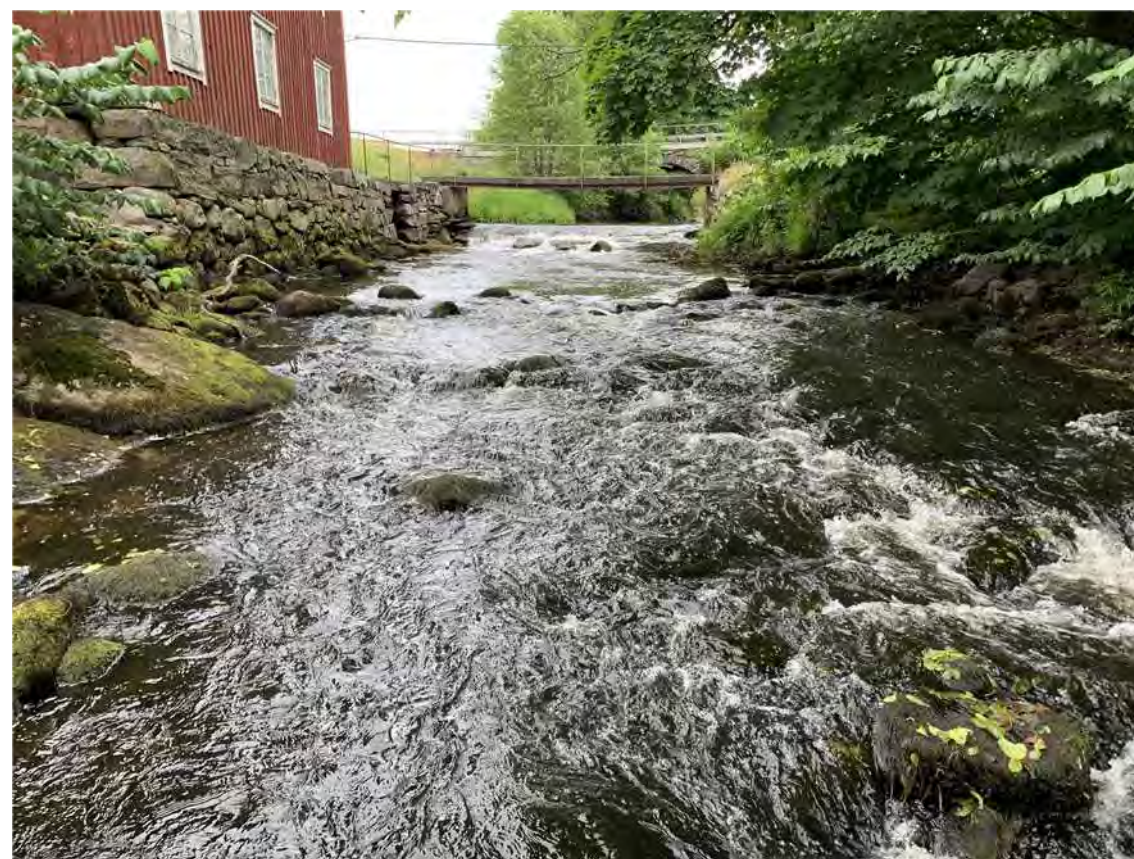
Figur 4. Uppströmsvy mot dammen fotograferat ca 20 m nedströms dammen
