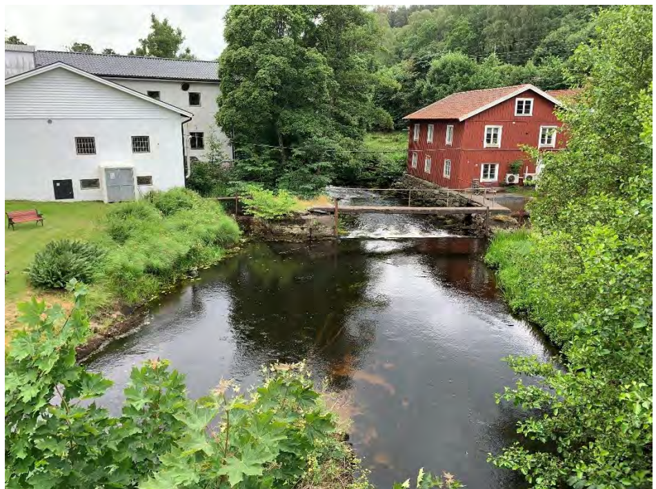
Figur 14. Nedströmsvy över åfåra och dammbyggnad, tagen från bron
