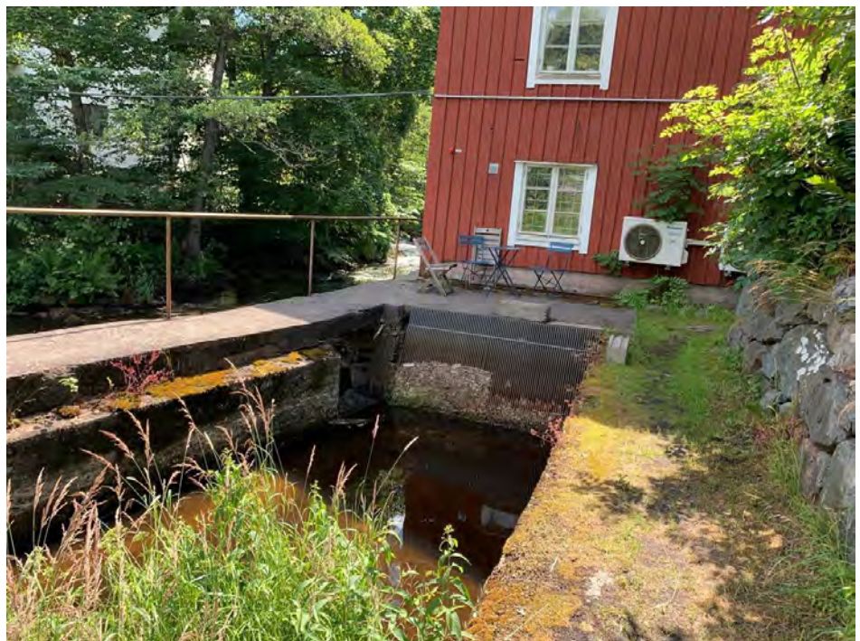
Figur 11. Nedströmsvy över höger kvarnintag med galler och flodutskov.
