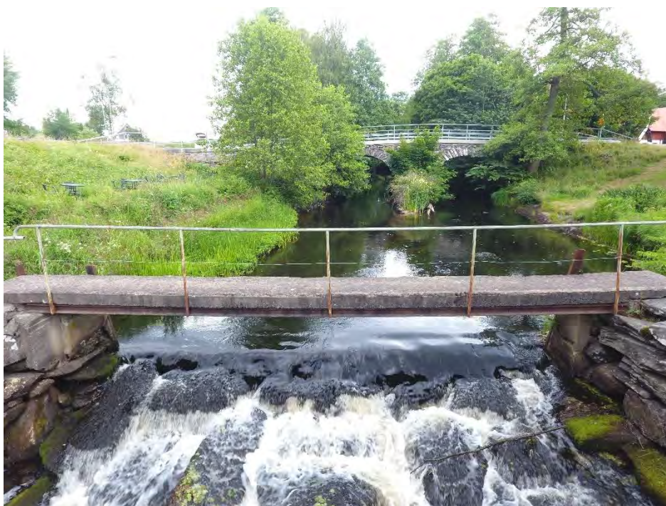
Figur 12. Uppströmsvy över dammbyggnad, åfåra och stenvalvsbro uppströms anläggningen
