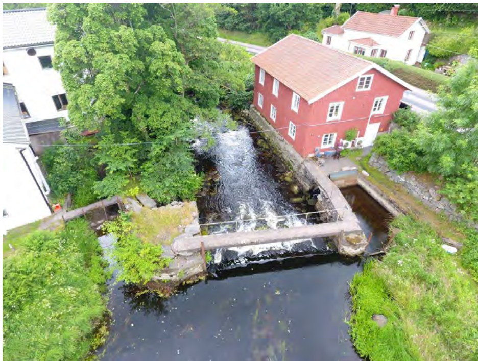
Figur 3. Nedströmsvy över anläggningen tagen med drönare. Dammbyggnaden vid Alafors kvarn med de båda inloppskanalerna, intag och översta delen av naturfåran.
