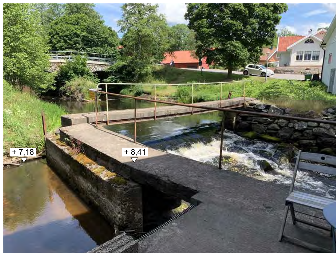
Figur 1. Högra kvarntaget med utskov till naturfåra och galler för intagsöppningen
