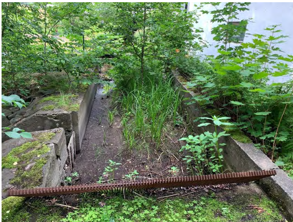
Figur 5. Uppströmsvy över vänster intagskanal nedströms betongklack. Intagsgaller och isutskov framför vänster kvarnintag.
