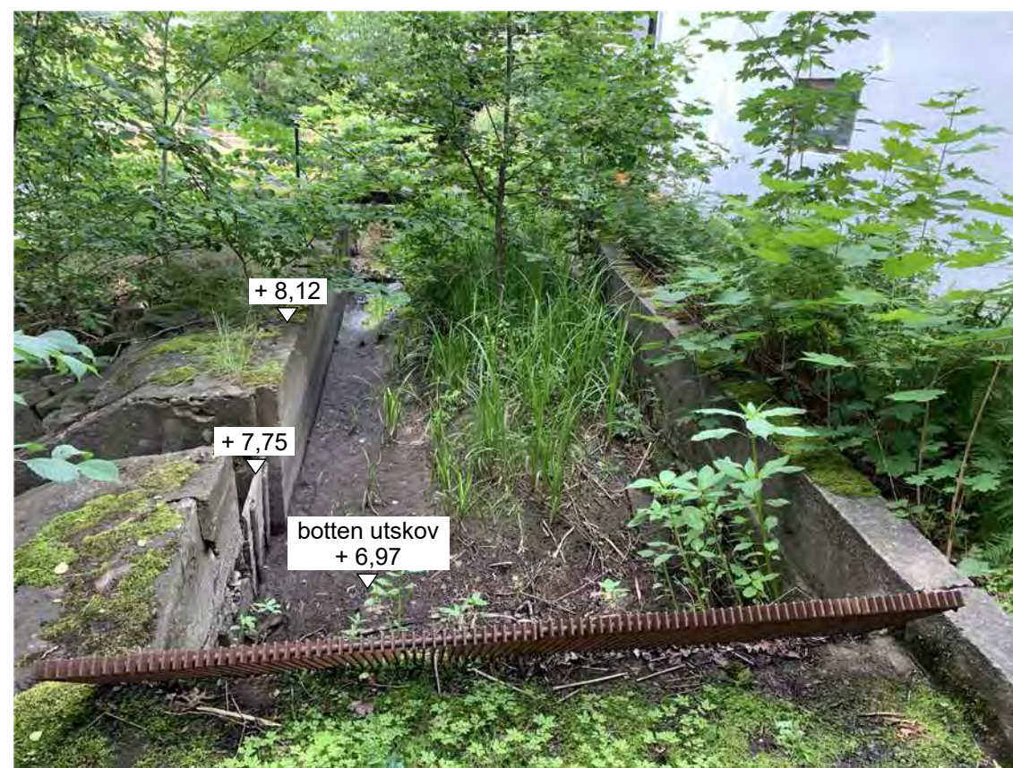
Figur 4. Vänstra inloppskanalen med isutskov och galler framför intagsöppningen
