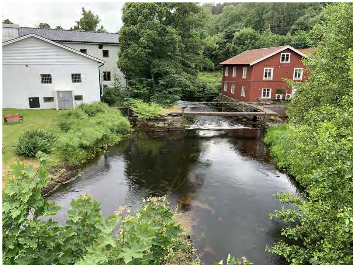
Figur 1. Vy ned mot dammbyggnaden från stenbron
