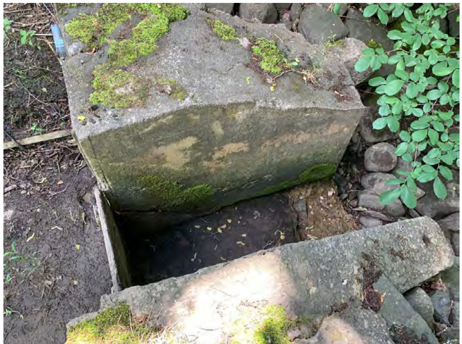
Figur 7. Isutskov framför vänster kvarnintag med träsättar
