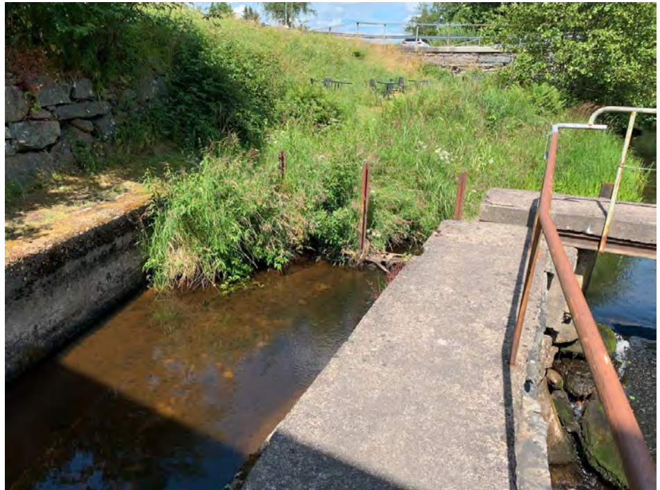
Figur 10. Uppströmsvy över höger inloppskanal med falsar för sättluckor.
