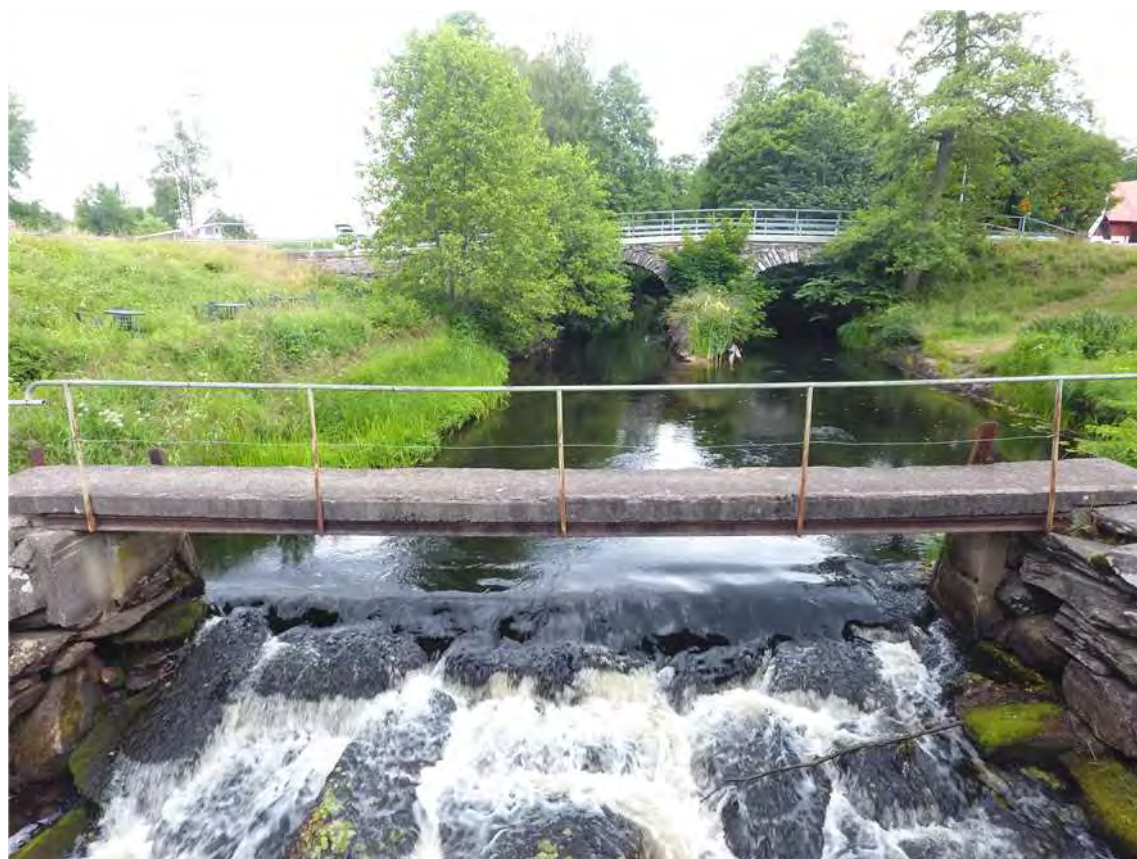
Figur 3. Uppströmsvy mot damm och stenbro
