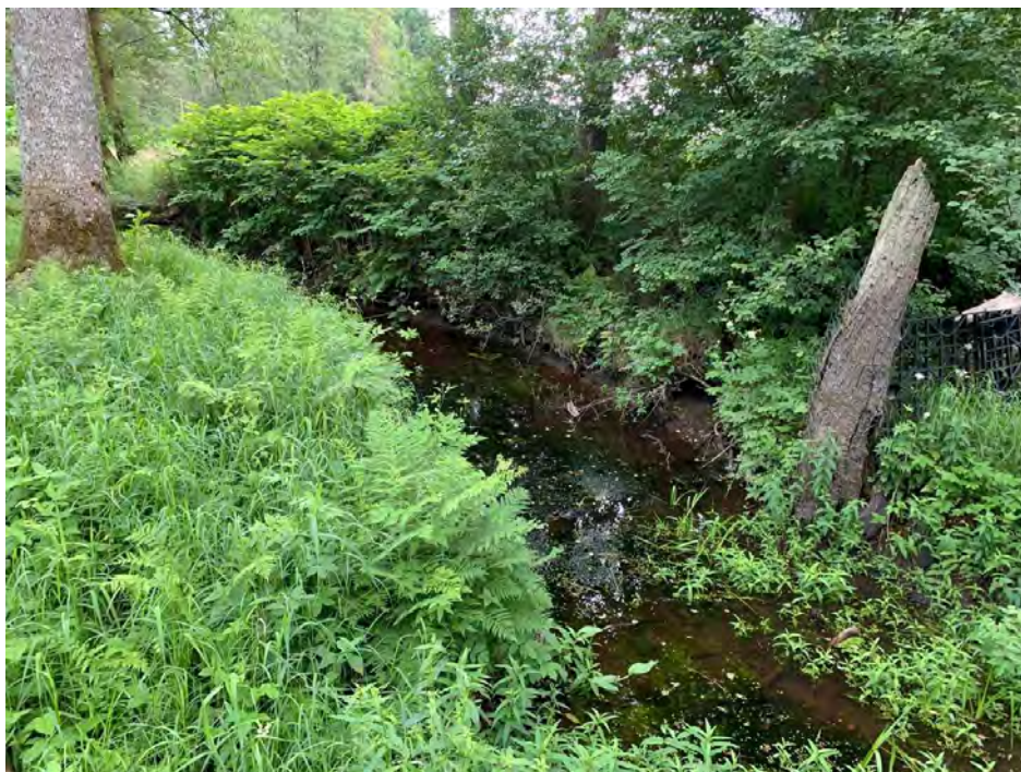
Figur 18. Uppströmsvy över vänster utloppskanal ca 90 m nedströms vänster kvarnbyggnad.
