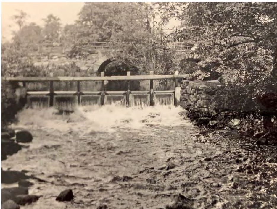
Figur 9. Kvarnbyggnaden före tidigare uppträsklingsåtgärder. Luckorna som fanns tidigare skapar här en högre dämning.
