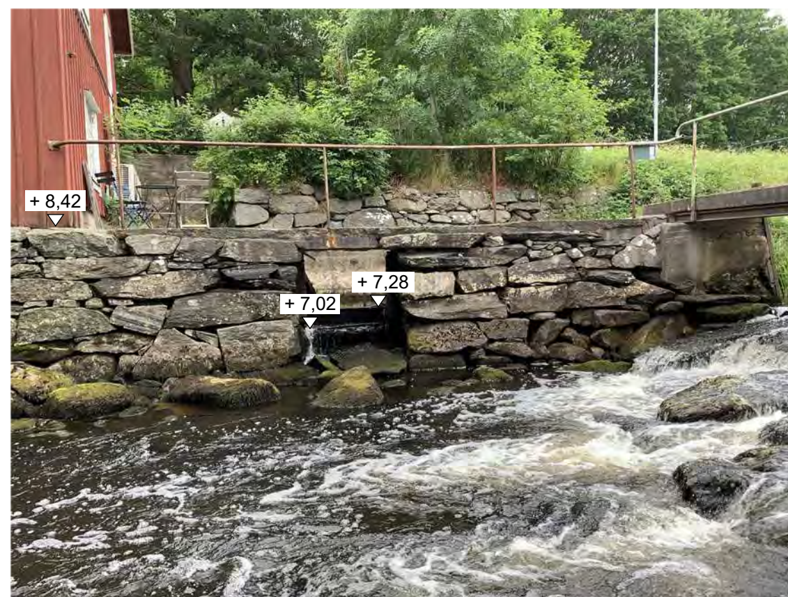
Figur 2. Utskovet i det högra kvarntaget fotograferat från åfåran nedströms dammen
