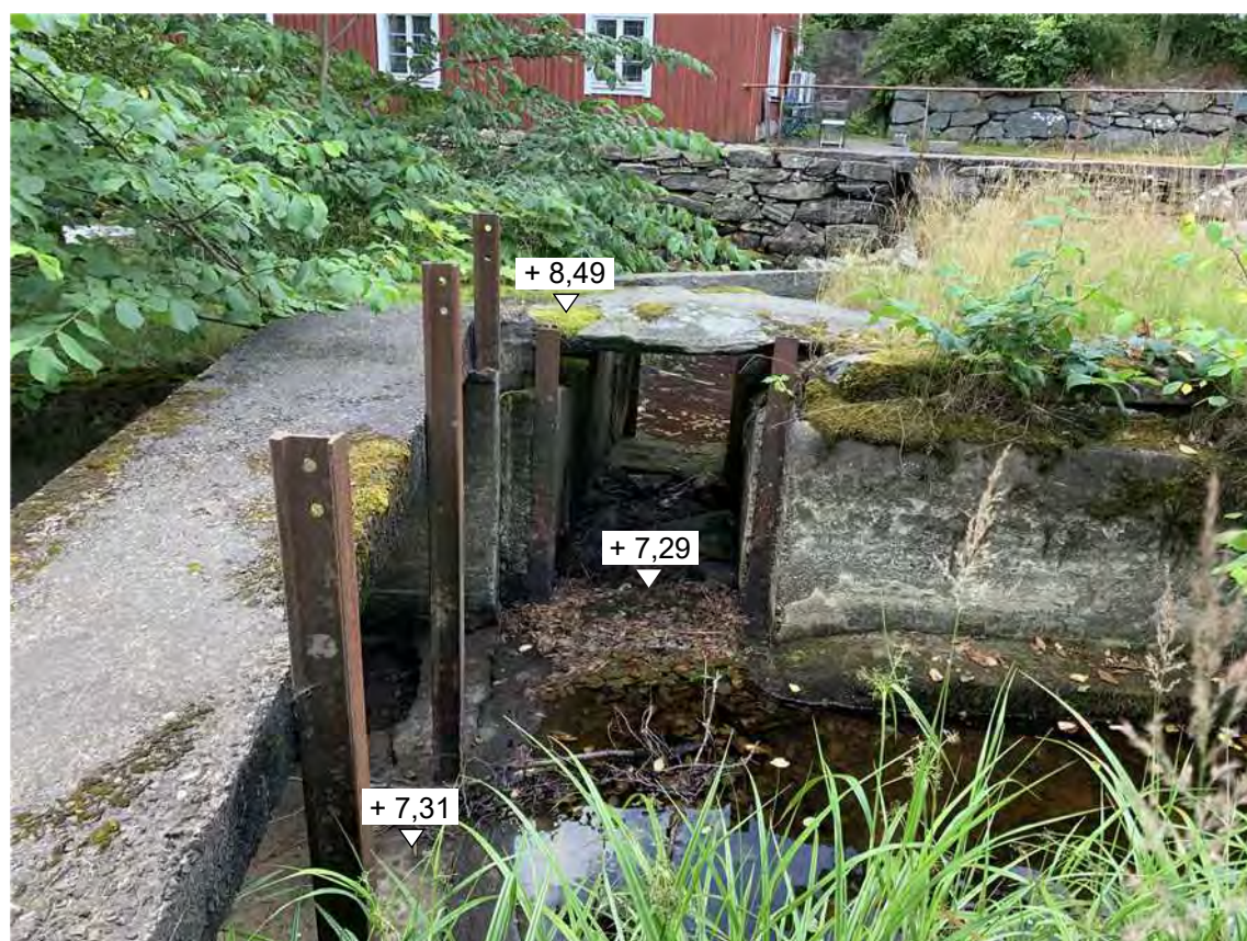
Figur 3. Vänstra kvarntaget med flodutskov och tröskel av betong
