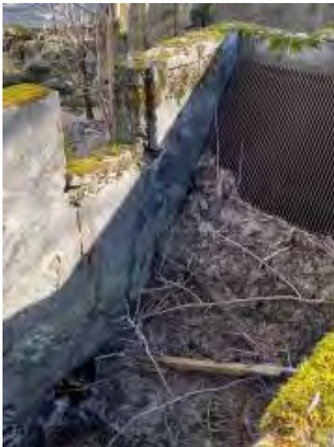
Figur 32. Öppning i betongränna nedströms höger kvarnbyggnad öppnas upp för återförsel av vatten till huvudfåra. Galler tätas.
