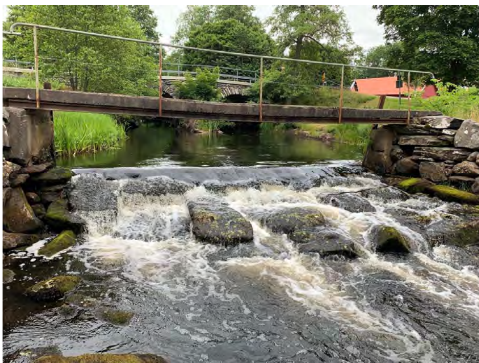
Figur 8. Uppströmsvy över det delvis upptrösklade skibordet.
