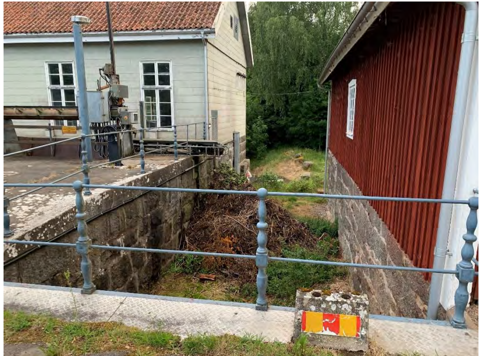
Figur 6. Före detta hjulgrav för kvarnen där intaget till den nya turbinen är planerat.
