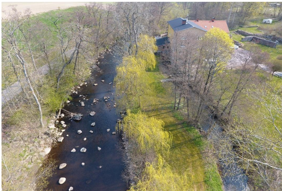
Figur 8. Uppströmsvy mot naturfårans (vänster) och utloppskanalens (höger).
