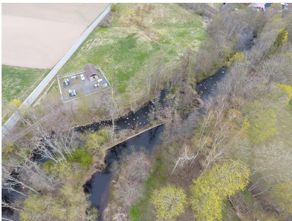
Figur 5. Övre delen av dammen, vy från södra sidan. Ån rinner från höger till vänster i bild.
