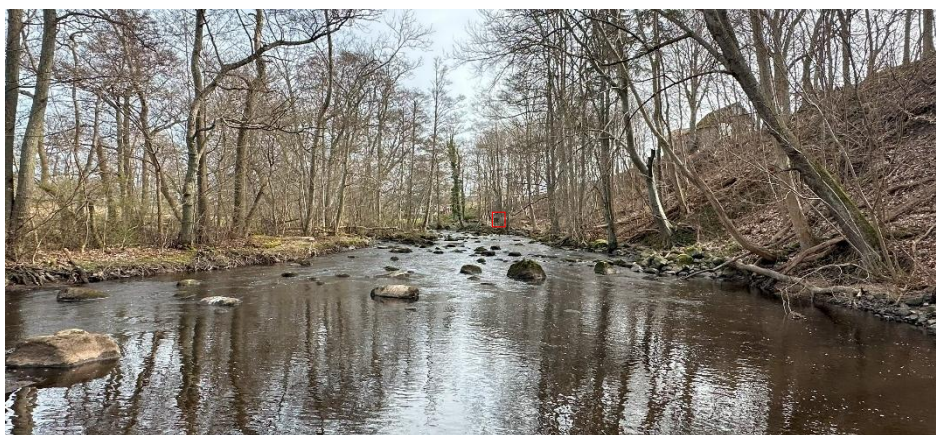
Figur 10. SMHI:s mätstation Ärrarp ligger ca 85 m uppströms dammen (röd markering). Foto från dammen i uppströms riktning.
