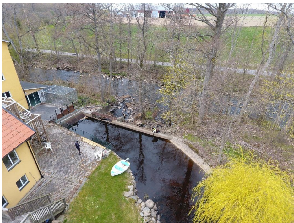
Figur 7. Nedströmsvy av intaget till kraftverket samt utskovet.
