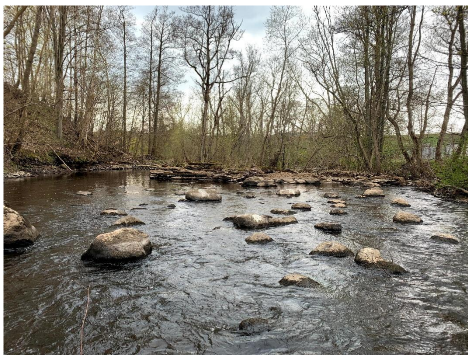
Figur 3. Nedströmsvy av starten på överfallsdammen. Till höger i bild finns en liten öppning för fiskvandring.
