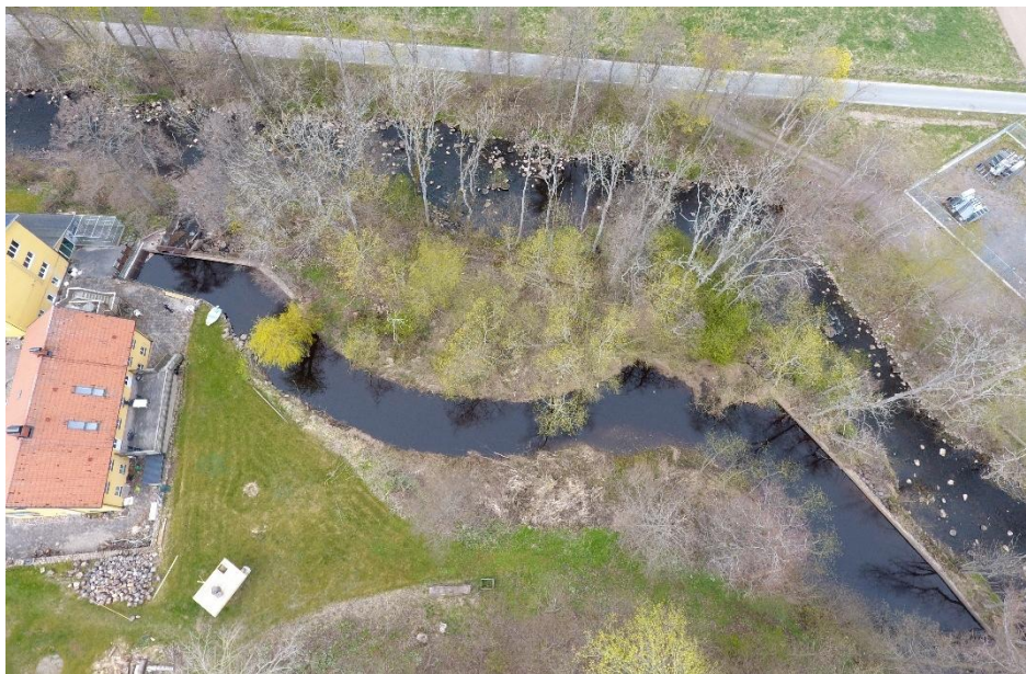
Figur 6. Nedre delen av dammen, vy från södra sidan. Där dammen vinklar sig och nedströms har sediment avlagrats närmst dammen vilket smalnat av intagskanalen. Ån rinner från höger till vänster i bild.
