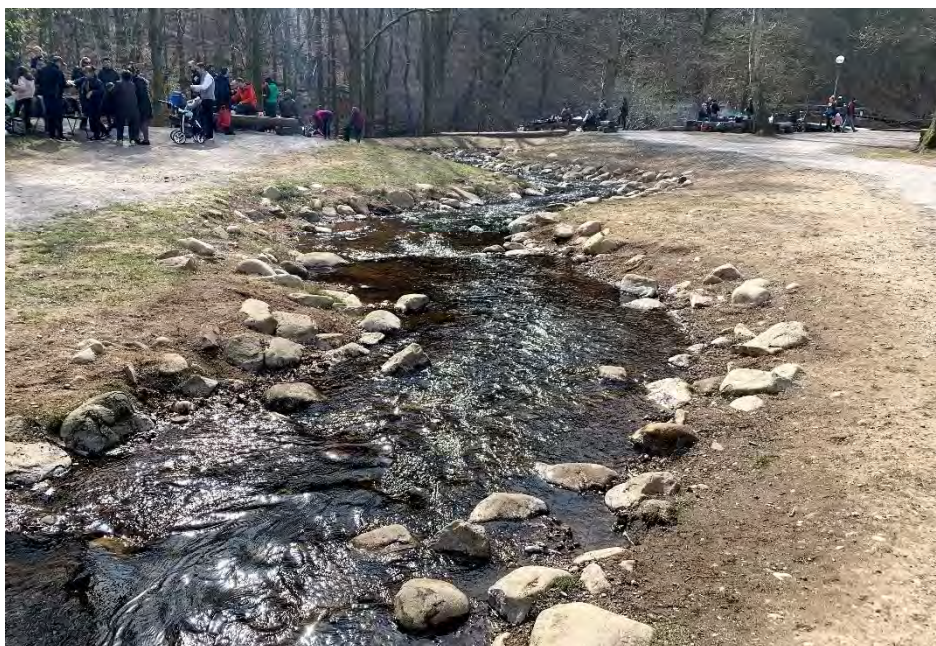
Figur 25. Exempel på omlöp vid Skäralid med ca 250 l/s och ca 2 % lutning.
