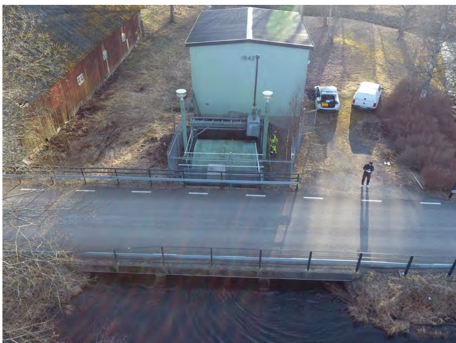
Figur 9. Intaget är utrustat med en segmentslucka rensmaskin och rensgaller, nedströmsvy.
