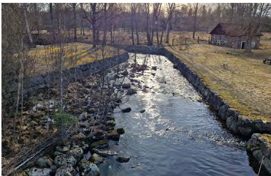
Figur 15. Nedströmsvy mot naturfåran från dammbyggnaden. Åfårans sidor är kallmurade ca 100 m nedströms dammbyggnaden.
