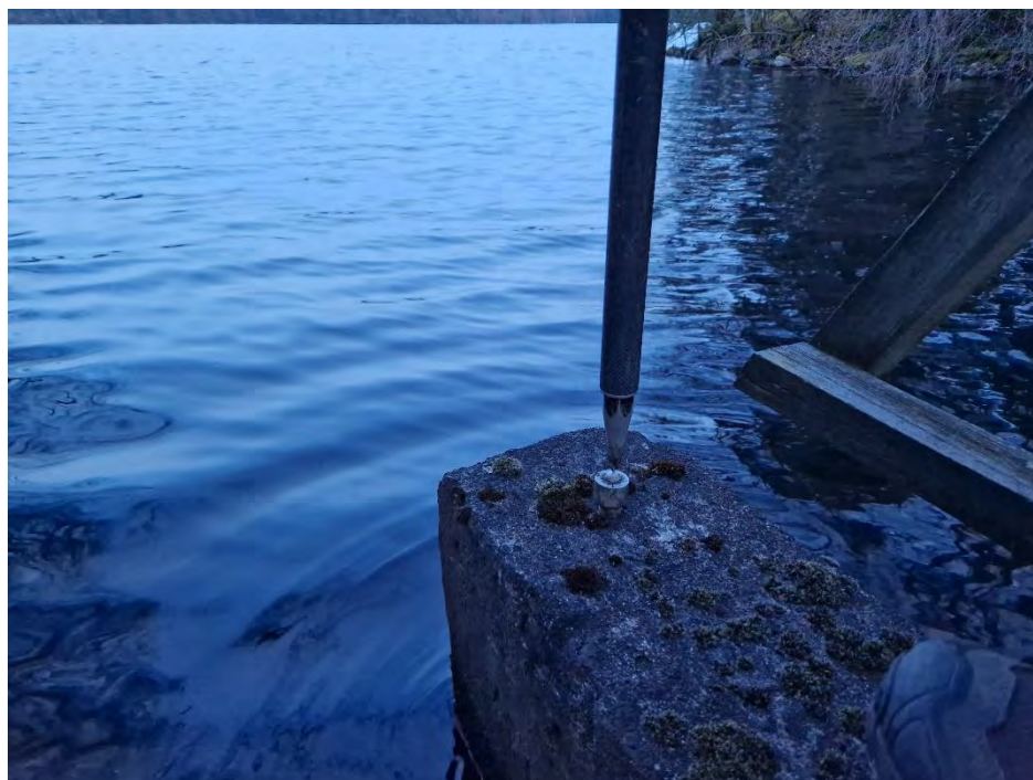
Figur 2. Fixpunkt för Böksholm övre belägen vid f.d. regleringsdamm vid Örkens utlopp, uppströmsväg mot Örken.
