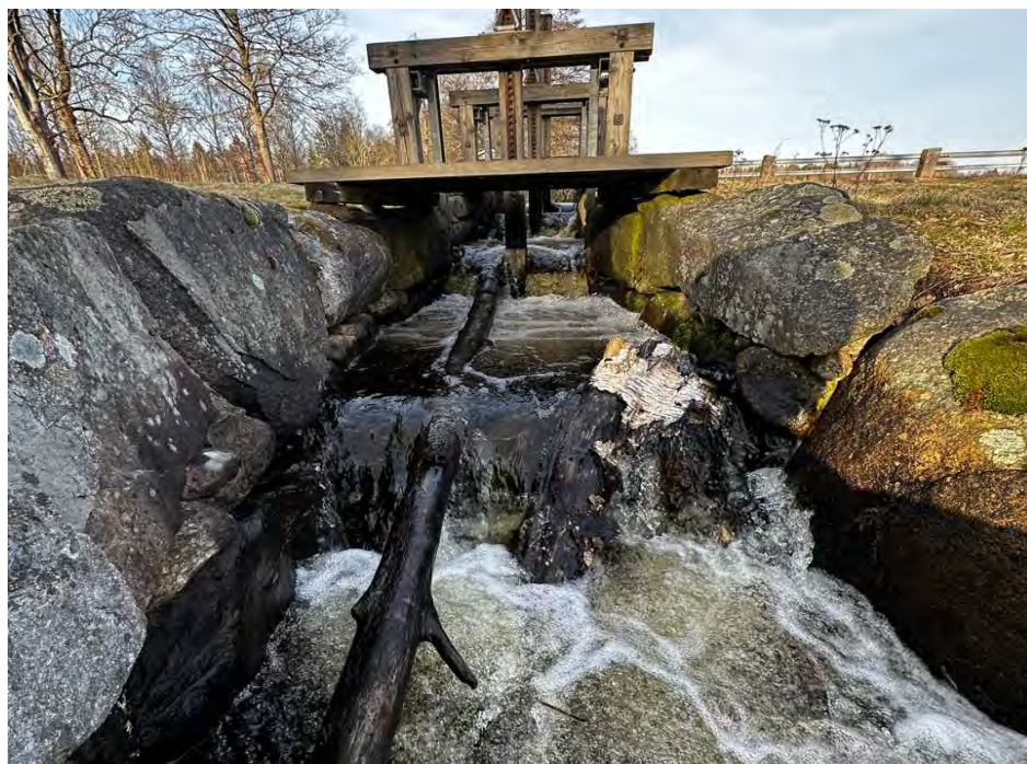
Figur 13. Uppströmsvy mot sektionen med trappsteg. Trappstegen regleras med spetluckor i trä bortsett från nedersta steget där vattnet faller över en stenklack.
