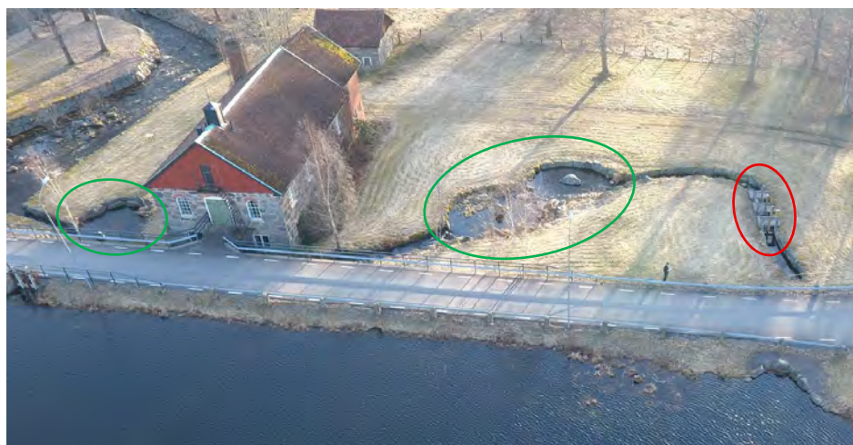
Figur 12. Nedströmsvy mot fiskvägen. Sektionen med trappsteg är markerad med rött. Vilopoolerna är markerade med grönt.
