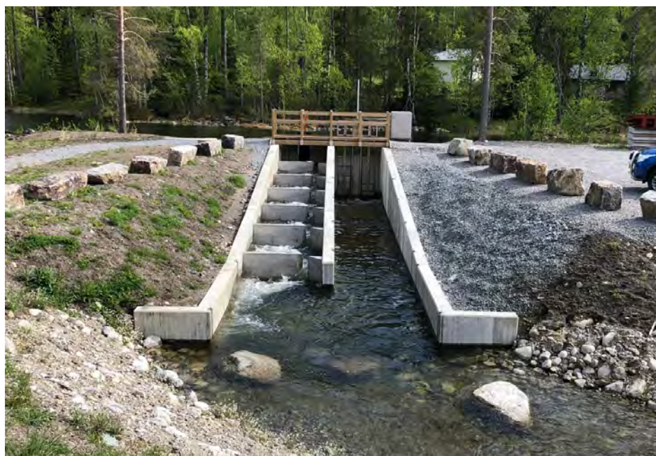
Figur 24. Exempel på reglerbart slitsutskov.
