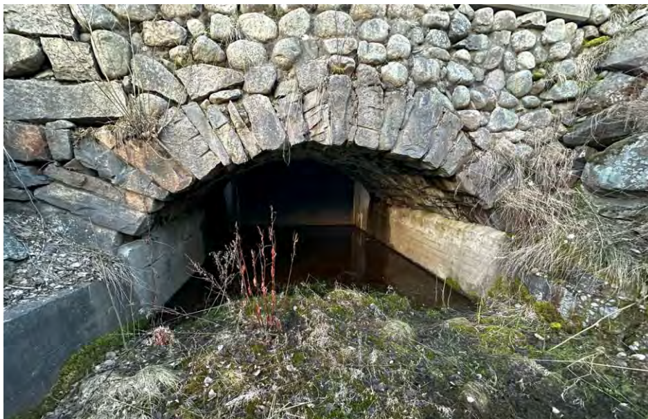
Figur 6. Uppströmsvy mot vänstra flodutskovet.
